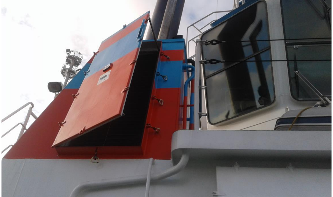
Kuva 5. BB-puolen korsteeniluukku. Huomaa alkuperäinen, mekaaninen aukipitotanko ja sangen pieni avauma. Kuva: Harju 2019.
