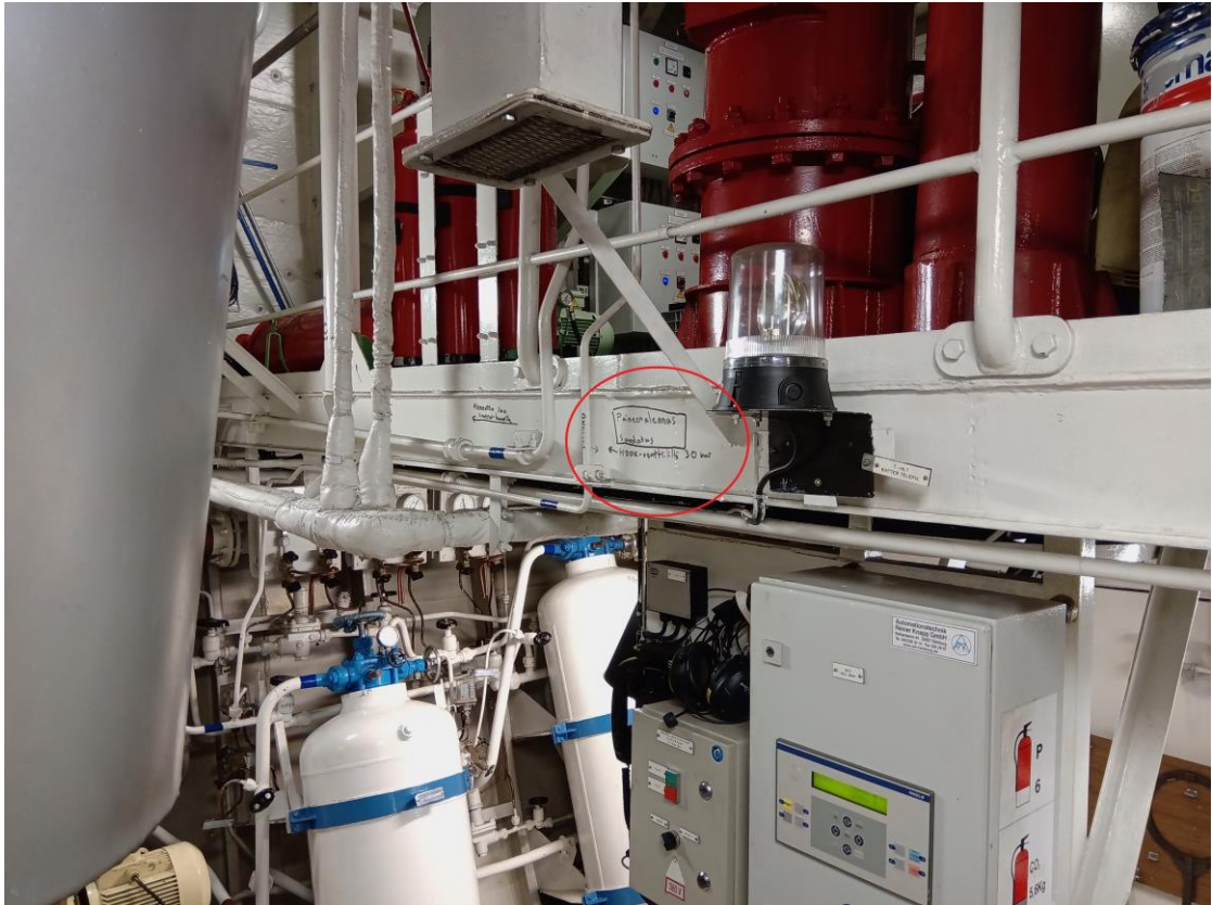
Kuva 11. Paineilman ensiöpuolen komponenttien sijoittelu konetopin takareunaan. Ympyrän sisällä näkyy laitteiden telineen sijoituspaikka. Kuva: Harju 2019.
