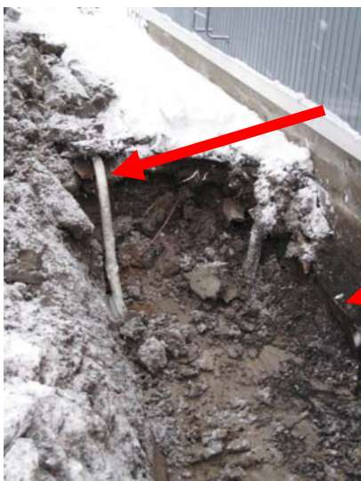
Kuva 4: Salaojaputken väärä sijainti ja korkeusasema perustukseen nähden
