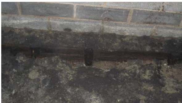
Kuva 9: Sisäpuolelle anturaan jätetty muottilaudoitus
