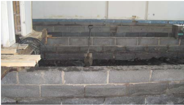
Kuva 8: Ryömintätilaa katkaisevia muureja
