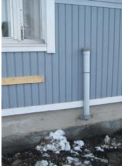
Kuva 7: Ryömintätilan tuuletusputki
