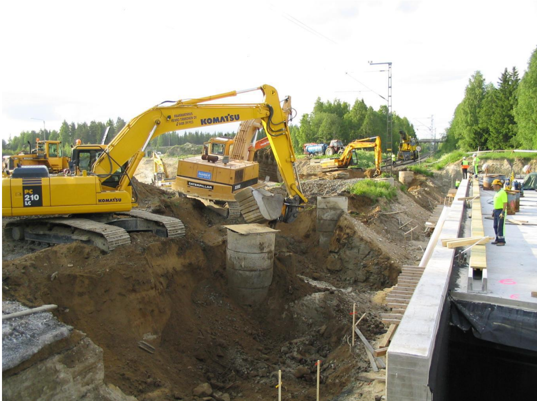
Kuva 3. Maanrakennustöitä. Kuva: Destia Oy
