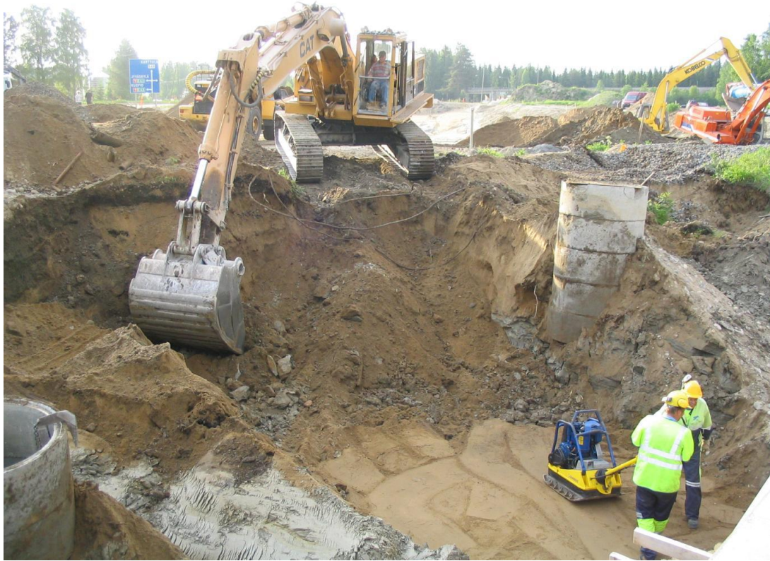
Kuva 4. Leikkaustöitä. Kuva: Destia Oy
