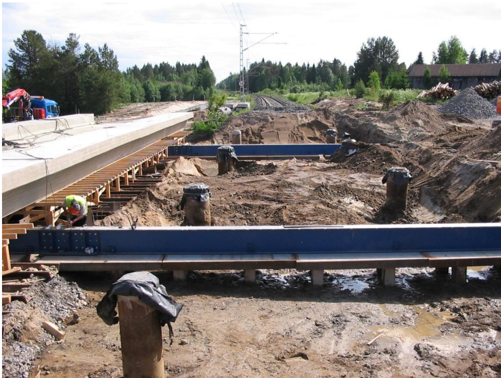
Kuva 1. Sillan siirtäminen. Kuva: Destia Oy
