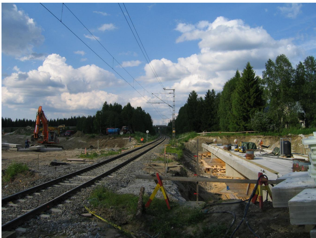
Kuva 2. Sillan rakentaminen radan viereen. Kuva: Destia Oy
