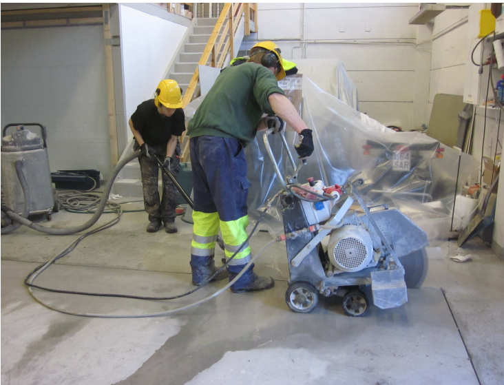
KUVA 11. Holvisahausta. Apumies imuroi sahauslietteen ja veden. Kuva Sanna Parkkonen
