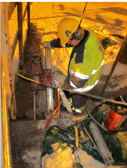
KUVA 21. Poraus porajalustaan kiinnitettyllä timanttikoralla Kuva Sanna Parkkonen
