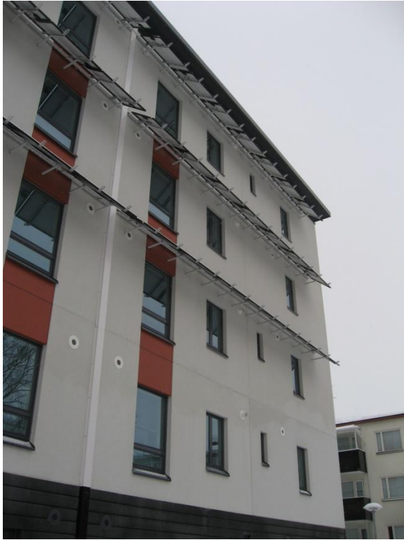
Kuvio 6. KUOPAS, nollaenergiatalo. Rakennuksen seinille on asennettu aurinkopaneeleita, jotka tuottavat sähköä rakennuksen autohallin tarpeisiin. Kerrostalo on muodoltaan pistetalo ja sen suunnittelussa on pyritty ottamaan myös huomioon ikkunoiden riittävä määrä. Kuva: Emma Suokas.
