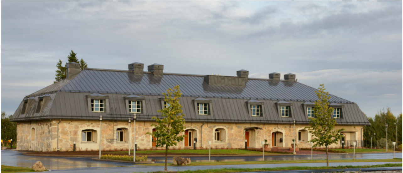
Kuva 20. Turun vanha kiviavetta on muutettu asunnoiksi
