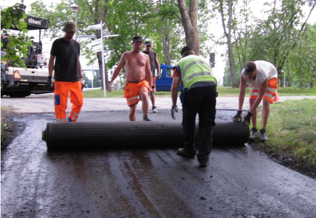
KUVA 2. Lujiteverkon asentaminen (Kuva: Sami Ruski 2010)
