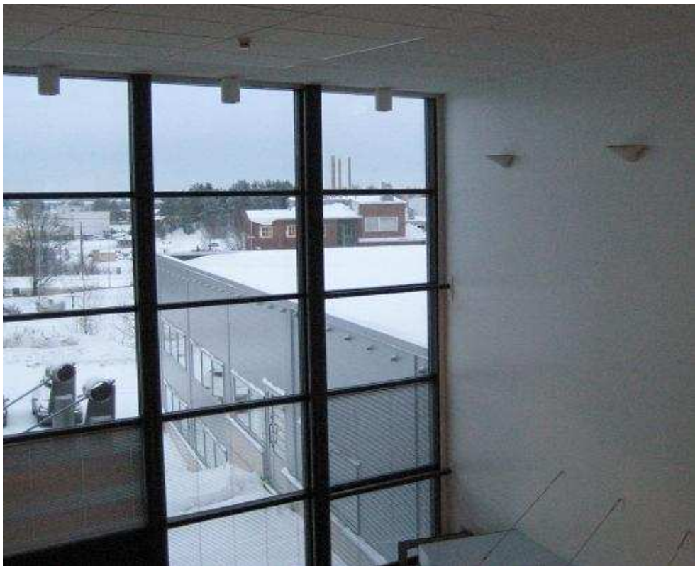
S-KUVA 14. Sisääntuloaulan valaistus vaikeasti huollettavissa.
