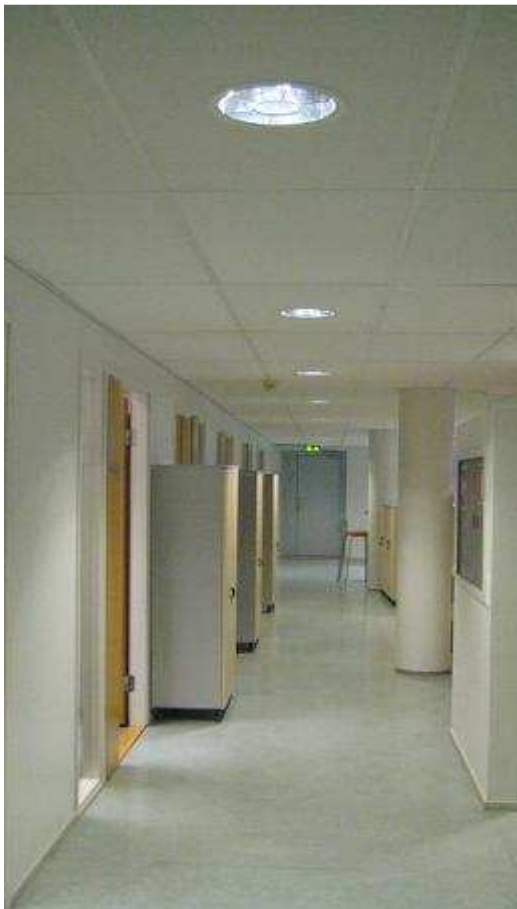
S-KUVA 12. Käytävätilojen valaistus.
