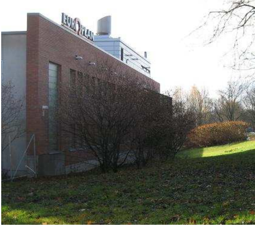
R-KUVA 3. Maanpinta laskee rakennusta kohden ylärinteen puolella.
