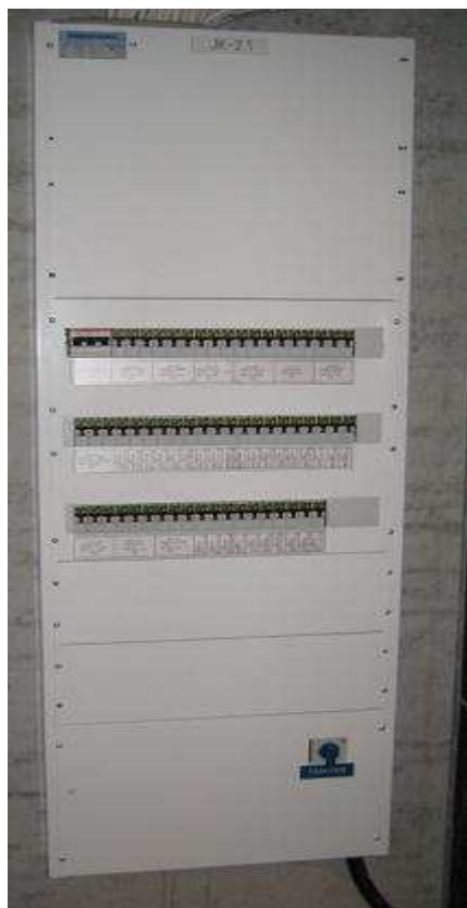
S-KUVA 3. Toimistokerroksen keskus
