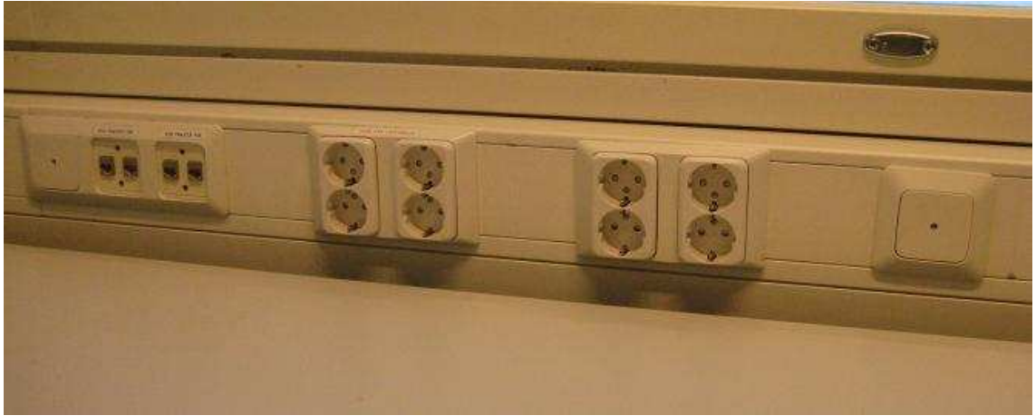
S-KUVA 7. Toimistokerroksen kouruasennus ja työpisteen sähkökalusteet.
