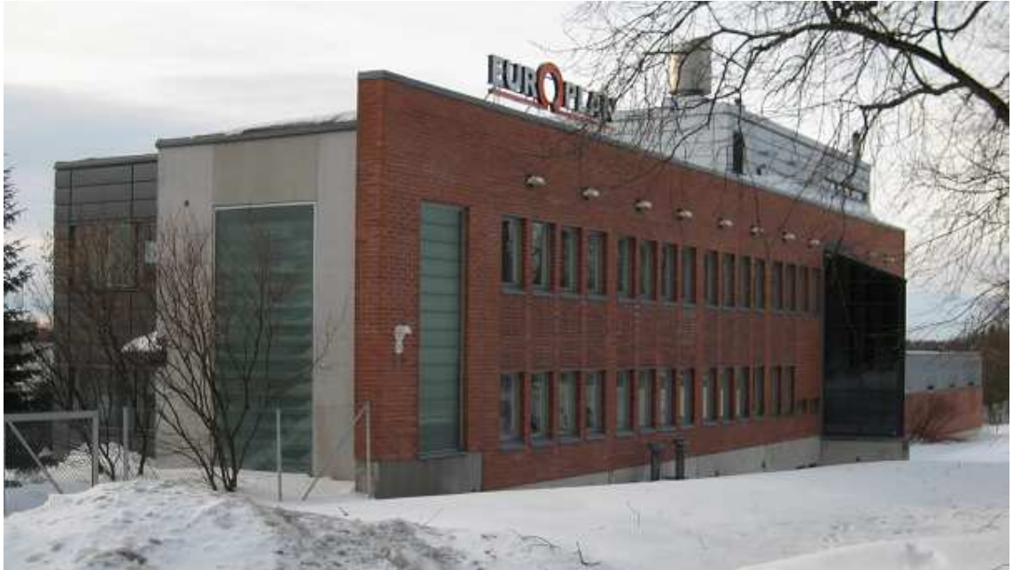
Kuva 1. Toimisto-osan paikalla muurattu tiilipinta.
