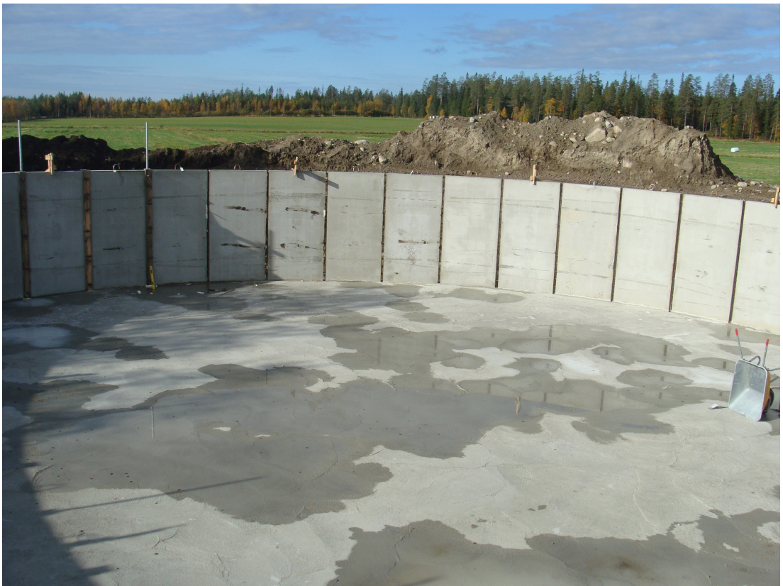
Kuvio 16. Lietesäiliön seinäelementit asennettuina
