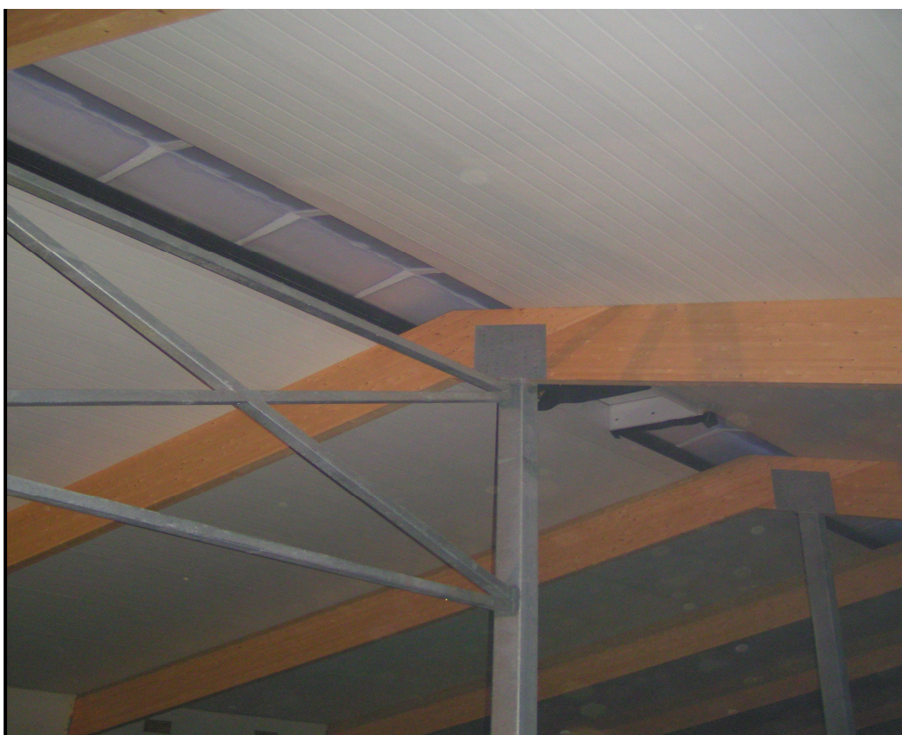
Kuvio 14. Termater-kattoelementit asennettuina
