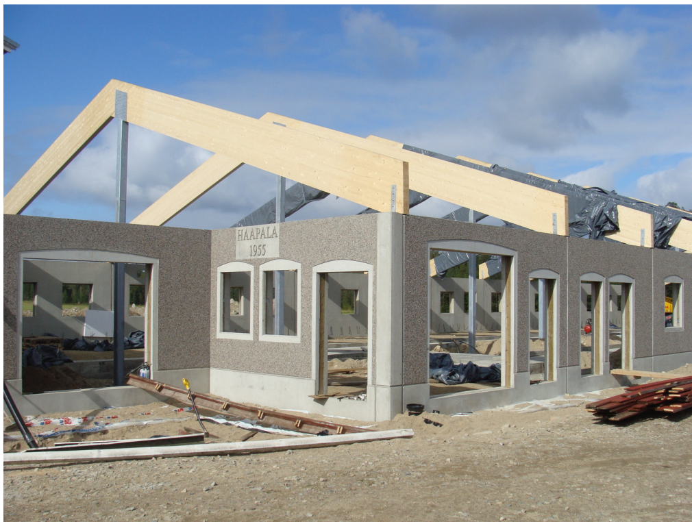
Kuvio 13. Liimapuupalkit asennettuina Sandwich-elementtien päälle
