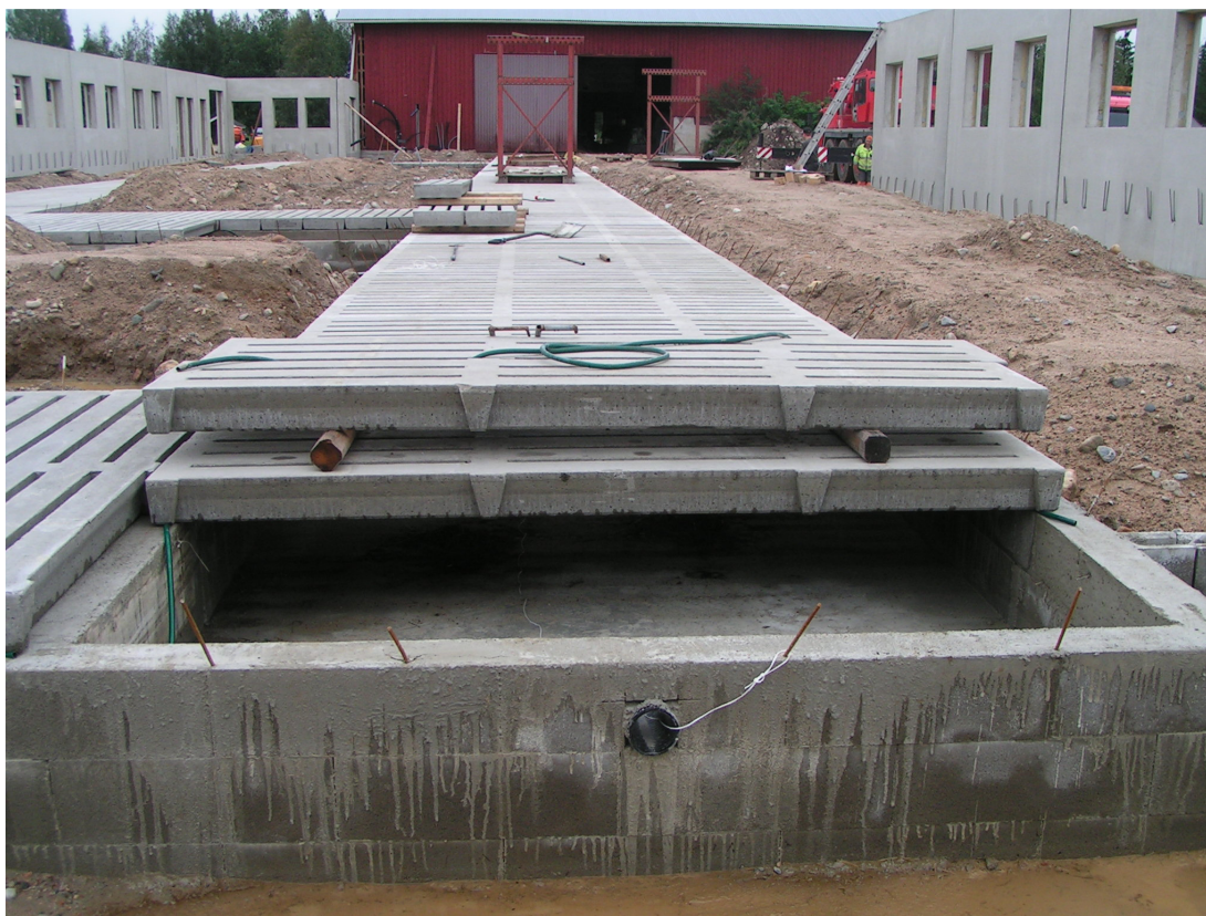
Kuvio 15. Ritiläpalkit asennettuna lietekanavan päälle
