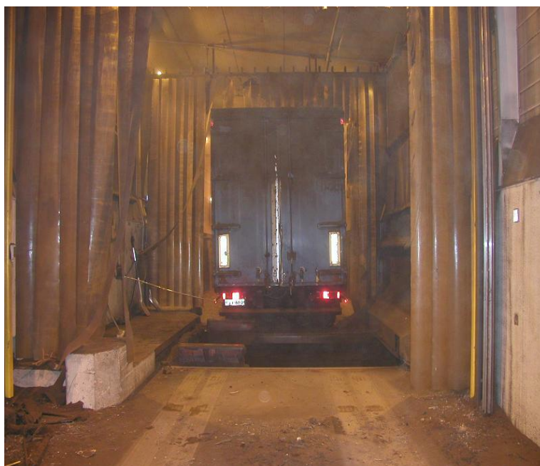
Kuva 4. Vastaanottohalli ja vastaanottotasku (kirjoittajan kuva).
