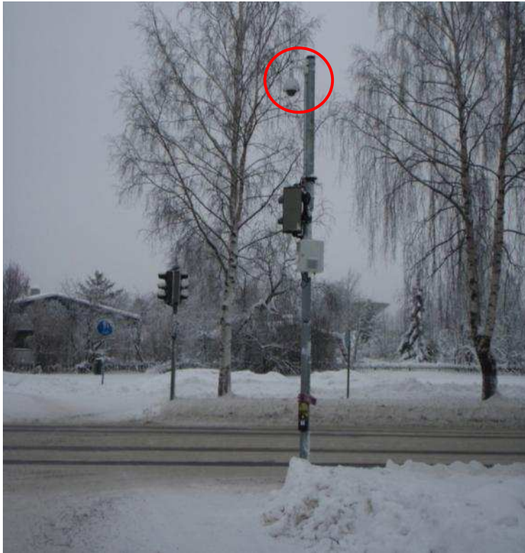
KUVA 20. Otos-kameran asennus liikennevalopylvääseen
