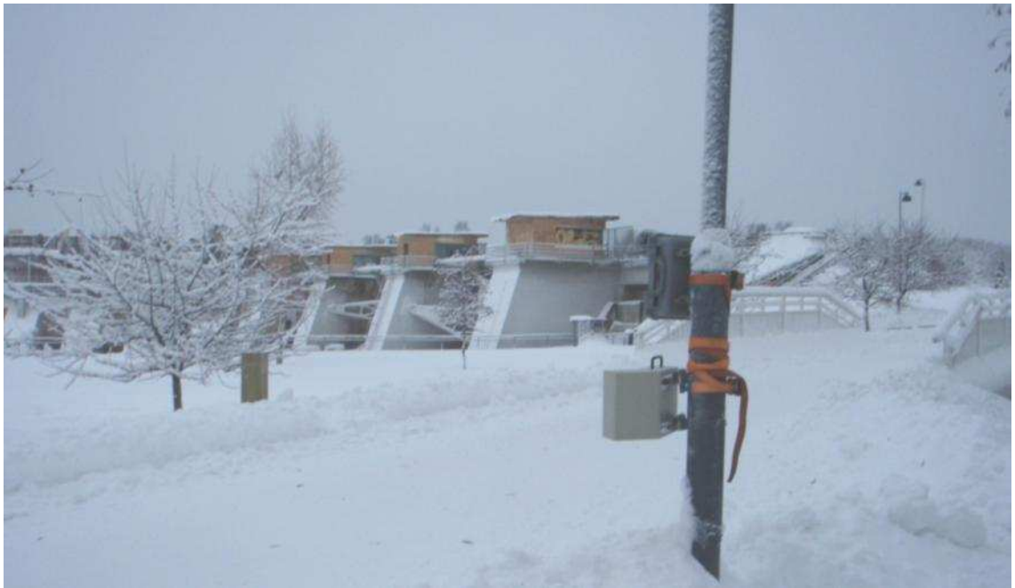
KUVA 23. Ainolanpuiston laskentapiste, taustalla patosilta
