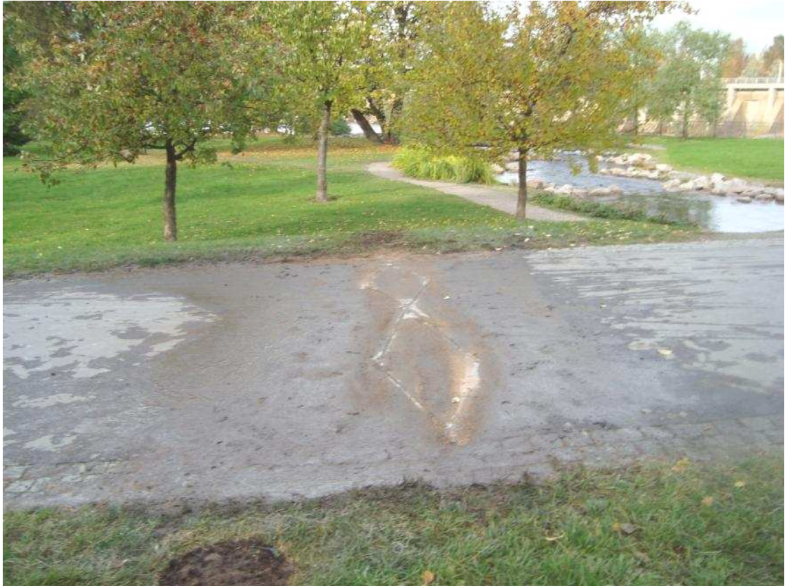
KUVA 18. ZELT-silmukoiden asennus loppukesästä 2010
