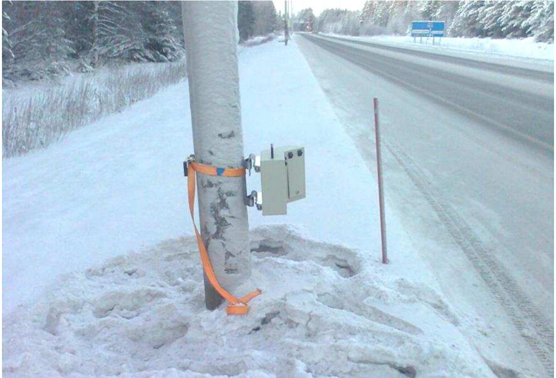
KUVA 14. Viacount II -tutkalaitteen asennus valaisinpylvääseen
