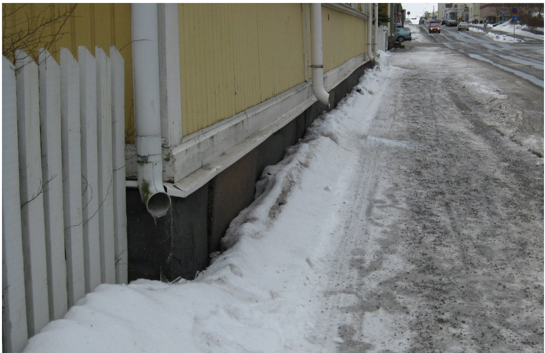
Kuva 57. Kiinteistön sadevesirännejä Rauhankadulla (Salla-Maija Vainio).
