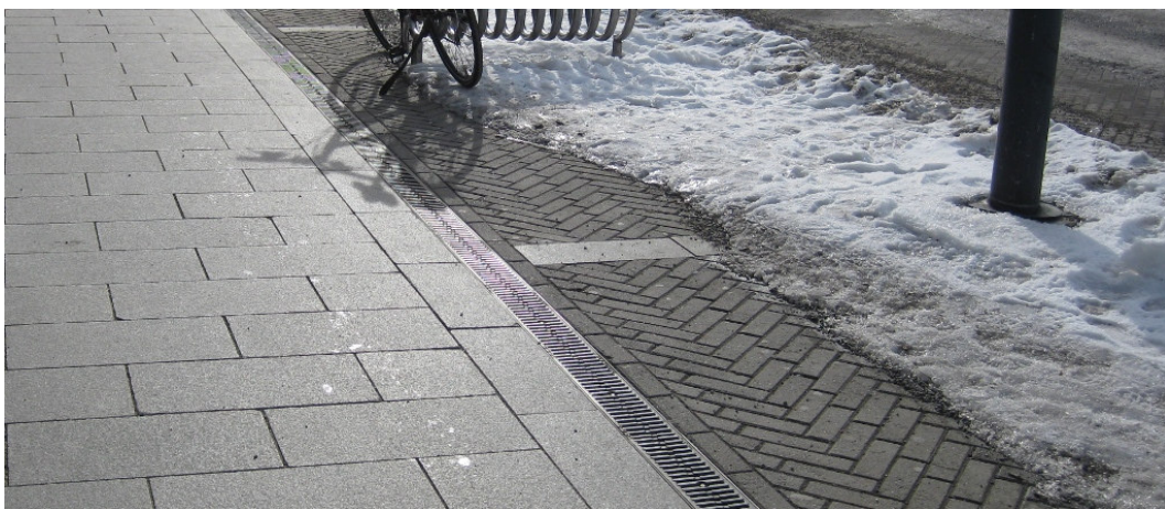
Kuva 15. Sadevesikouru jossa on ritilä päällä (Salla-Maija Vainio).
