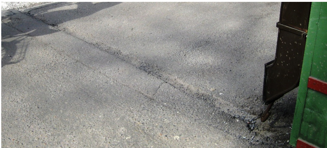
Kuva 14. Pitkädulla asfalttiin tehty sadevesikouru (Salla-Maija Vainio).
