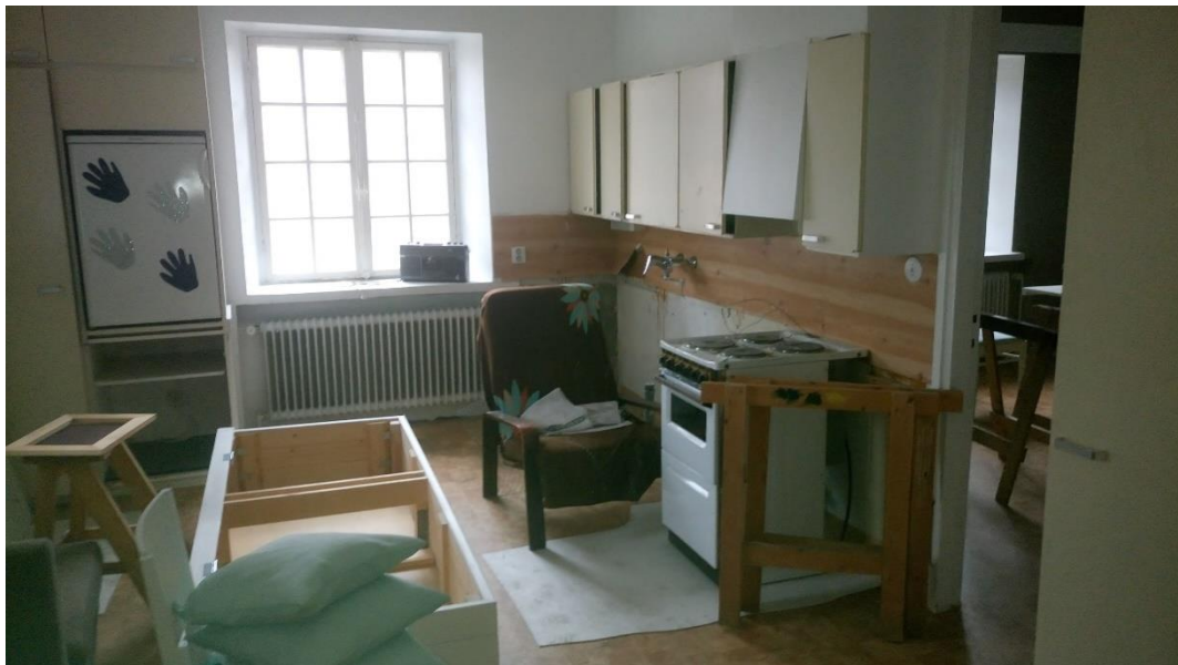
Figur 9. Bostadslägenhet under renovering.
