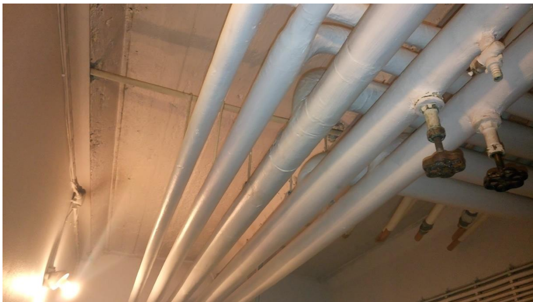
Figur 3. Vatten- och avloppsrör i gjutjärn.
