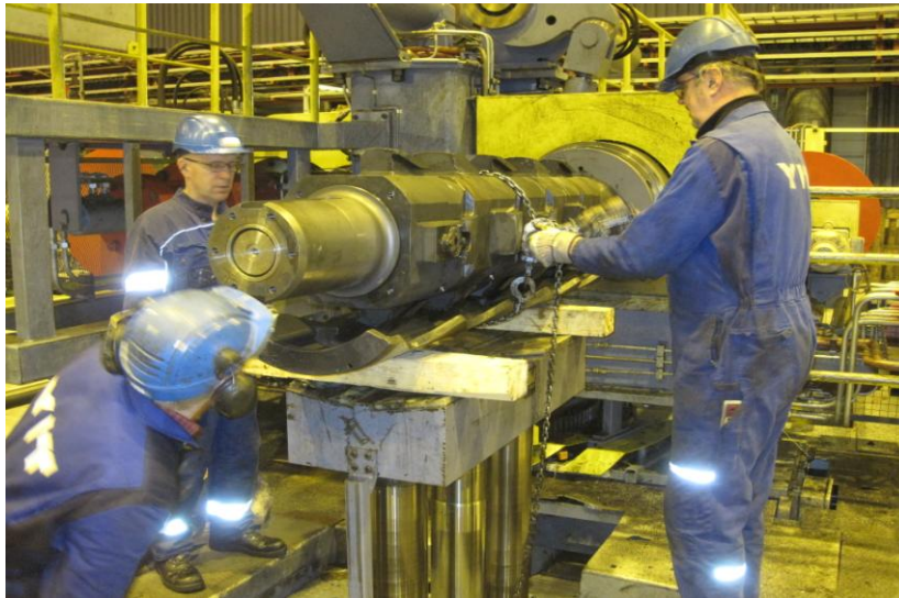
Kuva 32. Lohkon ja taljan asennus.
