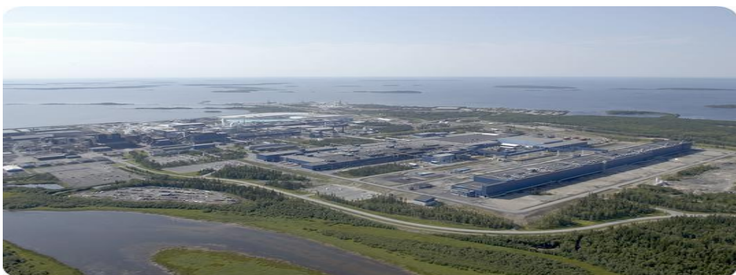
Kuva 9. Outokumpu Tornio Works, Junkkalanniemi Tornio /13/.
