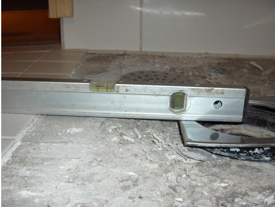
KUVA 4: Kaatojen korjaus tasoitteella vedeneristyksen päälle (Kuva: Lemminkäinen 2006)
