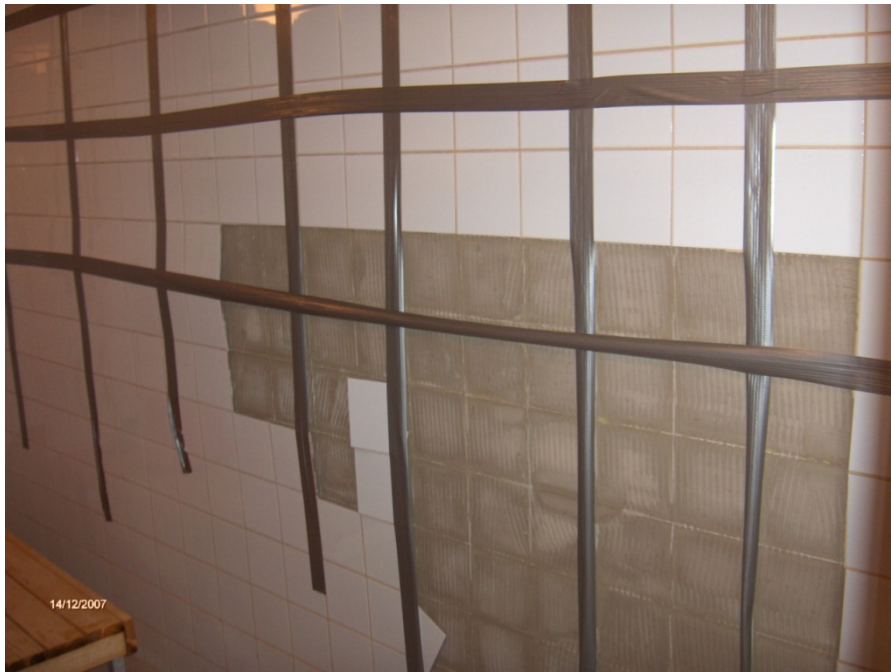
KUVA 2: Vielä seinällä olevat laatat on tuettu teipillä (Kuva: Lemminkäinen 2005)
