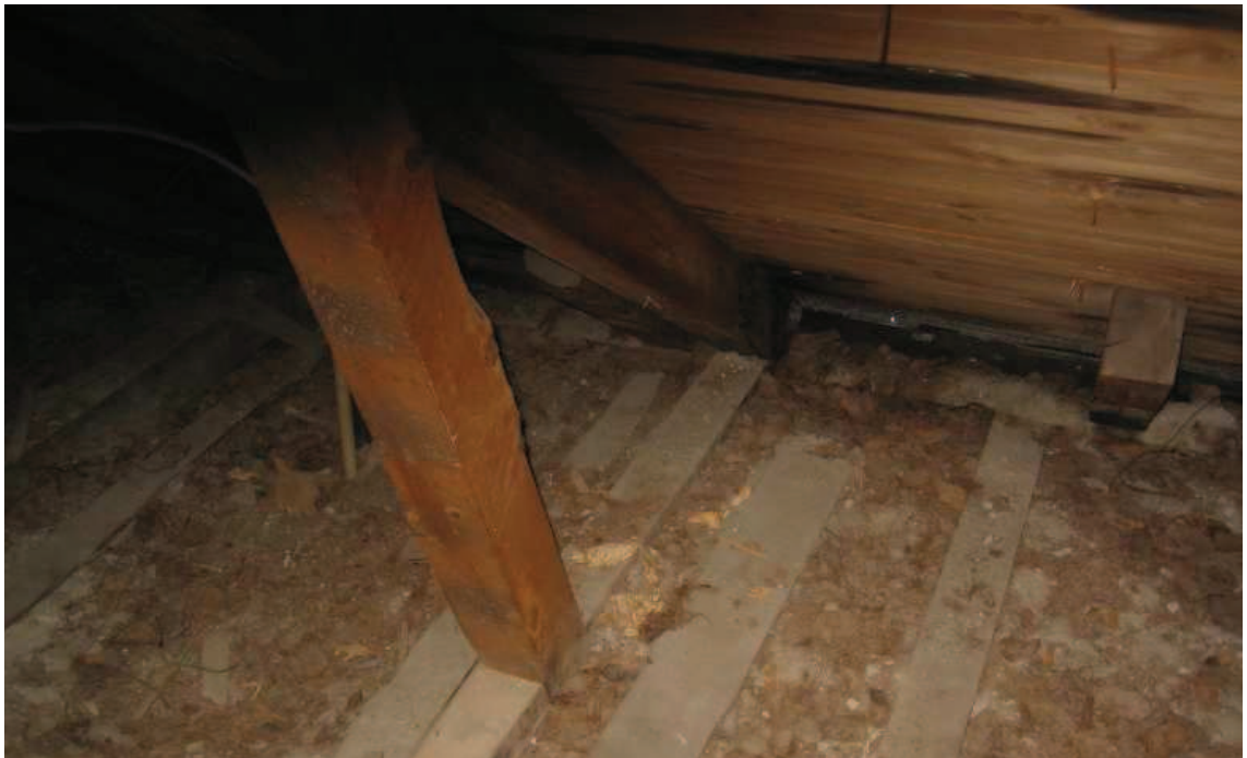
Kuva 4. Yläpohjan ulkoseinänpuoleinen reuna-alue ullakolta kuvattuna.
