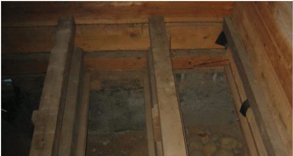
Kuva 2. Alapohjapalkkien tukeutuminen luonnonkivisokkeliin. Kuvassa on lisäksi sokkelissa oleva tuuletusaukko.
