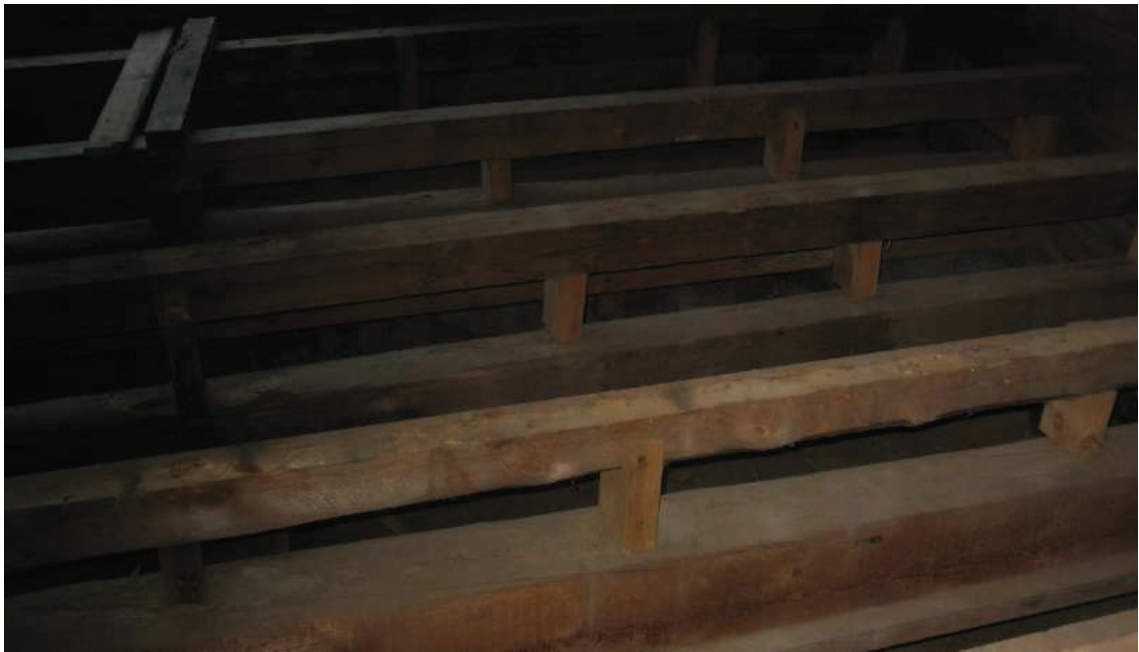
Kuva 5. Kylmän makasiinin alapohjapalkisto.
