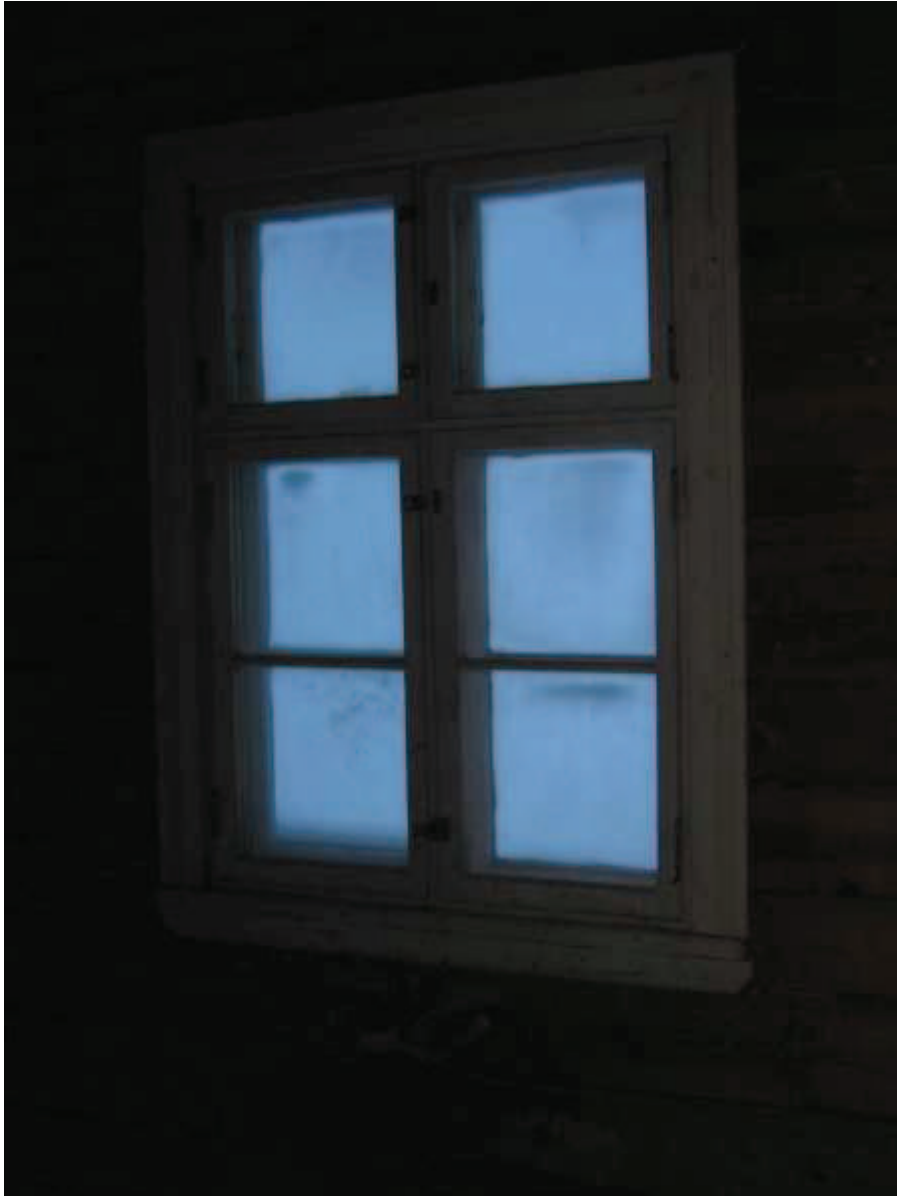
Kuva 8. Kylmän makasiinin toinen ulkoikkuna sisältäpäin kuvattuna.
