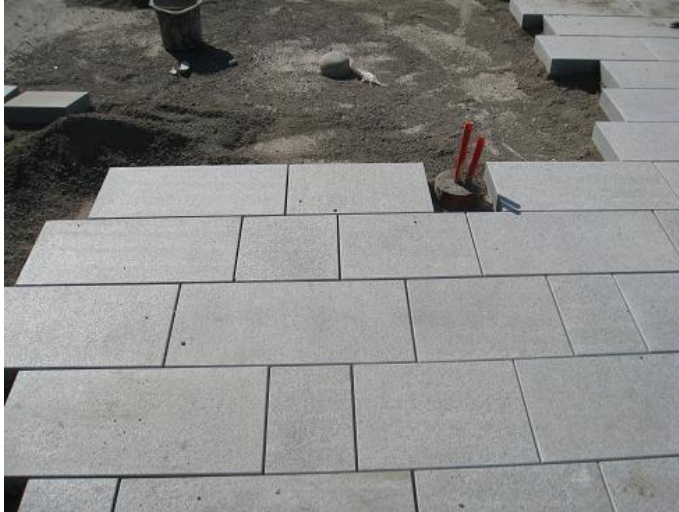
Kuva 23: Kivilaattoja asennettuna asfaltin päällä olevalle maakostealle betonille
