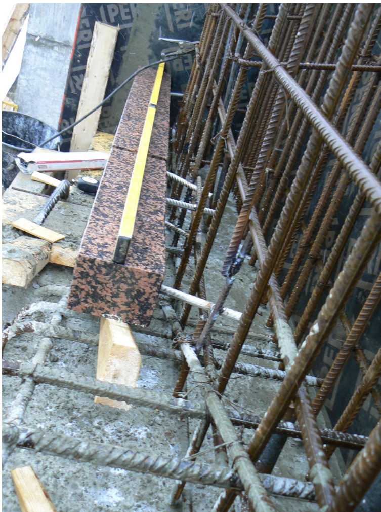
Kuva 30: Massiivikivien taustakiinnitykset hitsattuna.
