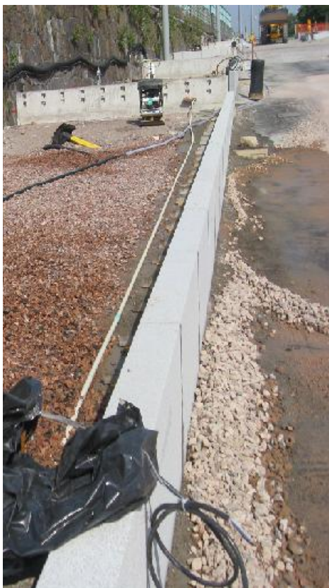
Kuva 25: Reunakivimuuri asennettuna. Nurmikkoallas vasemmalla täytetään murskeen ja mullan sekoituksella.
