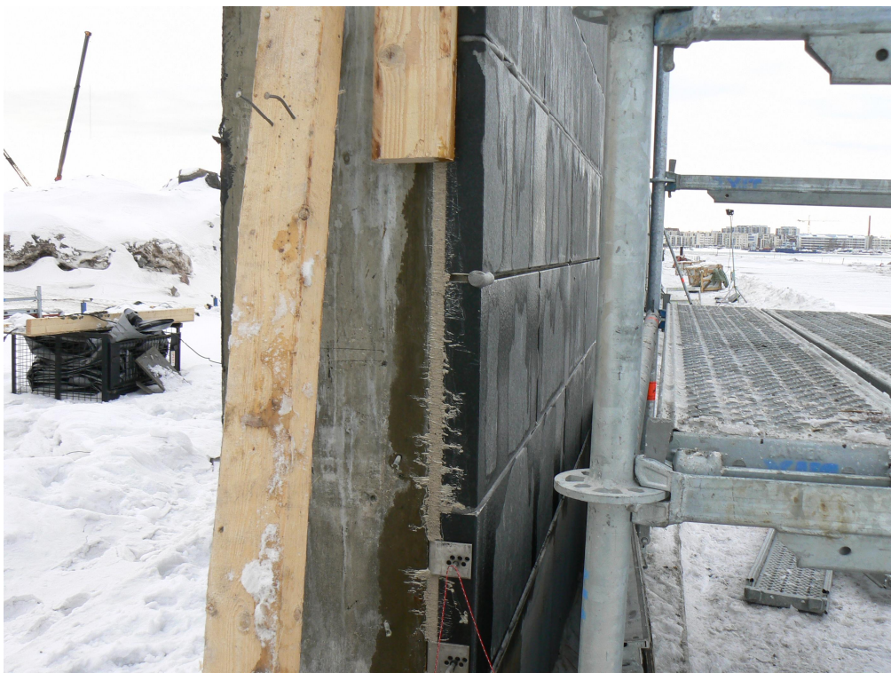
Kuva 28: Luonnonkivellä verhoillun betonimuurin rakenne.
