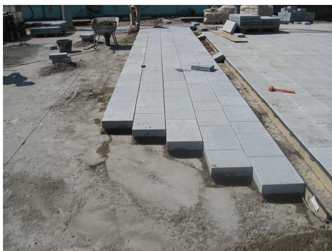
Kuva 31: Musiikkitalon luonnonkivilaatoituksen rakentamista kesällä.
