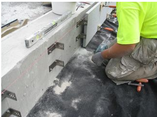
Kuva 26: Muurin verhousta luonnonkivellä
