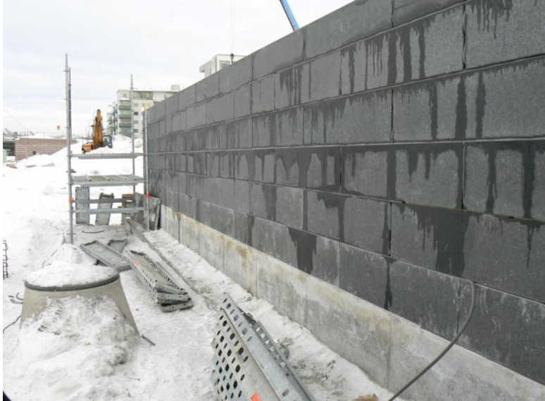
Kuva 6: Muuriverhouksen rakentamista talvella
