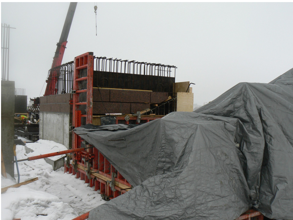
Kuva 29: Tukimuurin ylälaitaan asennettavat massiivikivet, taustalla aikaisemmin valmiiksi saatu tukimuuri.
