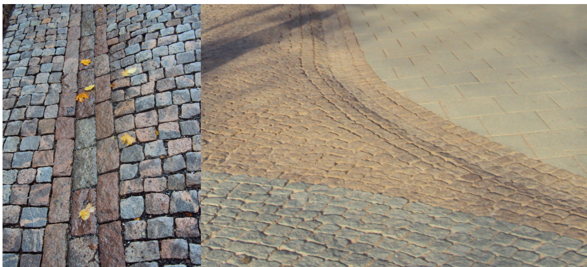
Kuva 12 ja 13. Hulevesien johtamisratkaisuja keskusta-alueilla (Hakola 2010).
