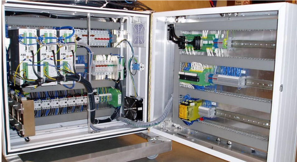
KUVIO 19. Ohjauskeskus avattuna ja lähes valmiiksi kalustettuna.
