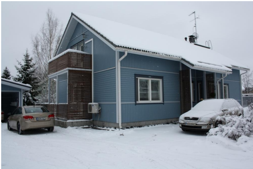
Kuva 1. Kohde kosteusmittausten aikaan.
