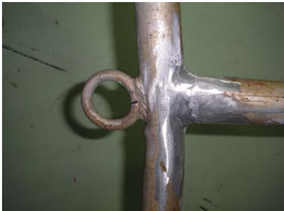
Kuva 19: Paikattu kulkusillan alumiinikaide.
