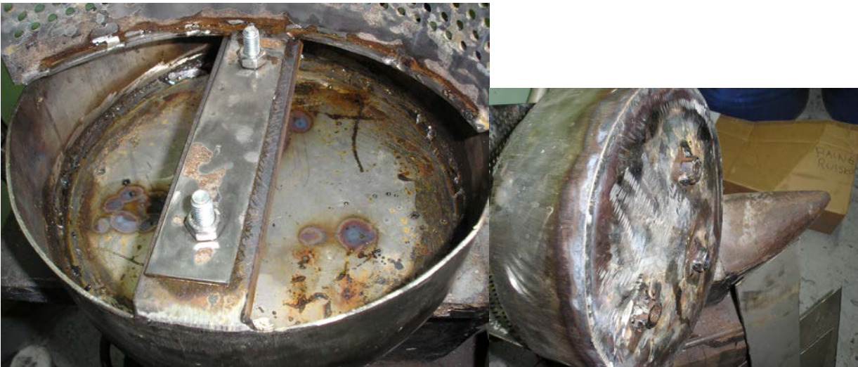
Kuvat 10 ja 11: Saumat on hitsattu Esab 48.00 -emäspuikolla. Materiaali on keskipalkkia lukuun ottamatta RST.
