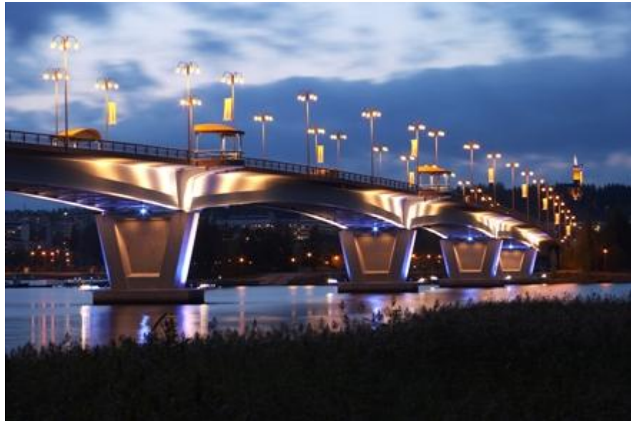
Kuva 2. Kuokkalan silta. Yksi Jyväskylän tunnetuimmista valaistukohteista.
