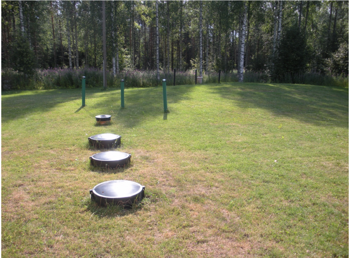
KUVA 12. Kolmilinjainen maasuodattamo vaatii runsaasti tilaa. Jäteveden purku tapahtuu metsän laidalta alkavaan avo-ojaan (Teräväinen 2010).
