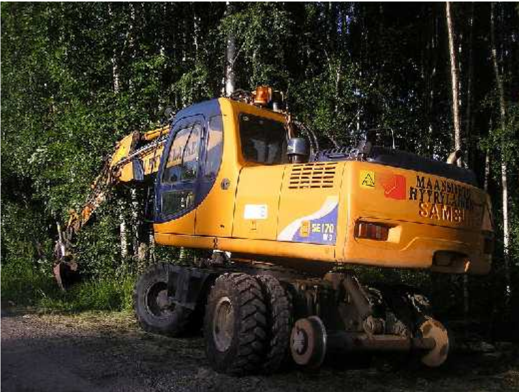
Kuva 5. Kiskopyöräkaivinkone (Antti Leppänen)
