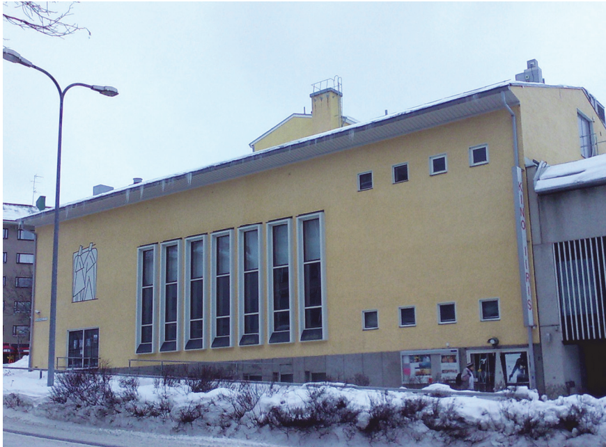
Kuva 3. Kansantalon Saimaankadun julkisivu sekä Kino Iiriksen sisäänkäynti.
