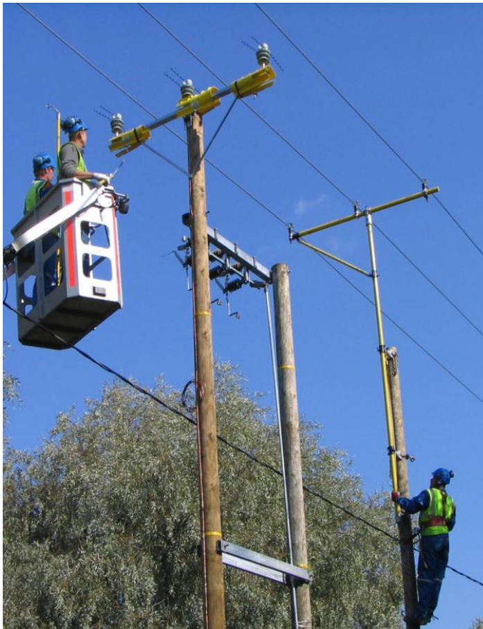
KUVA 5. pylvään vaihto väliaikaista pylvästä apuna käyttäen (Pitkänen 2010)
