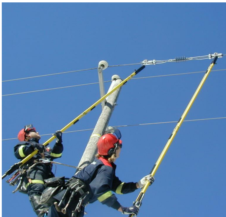
KUVA 1. JT-katkopaikan rakennus (Pikänen 2009)
