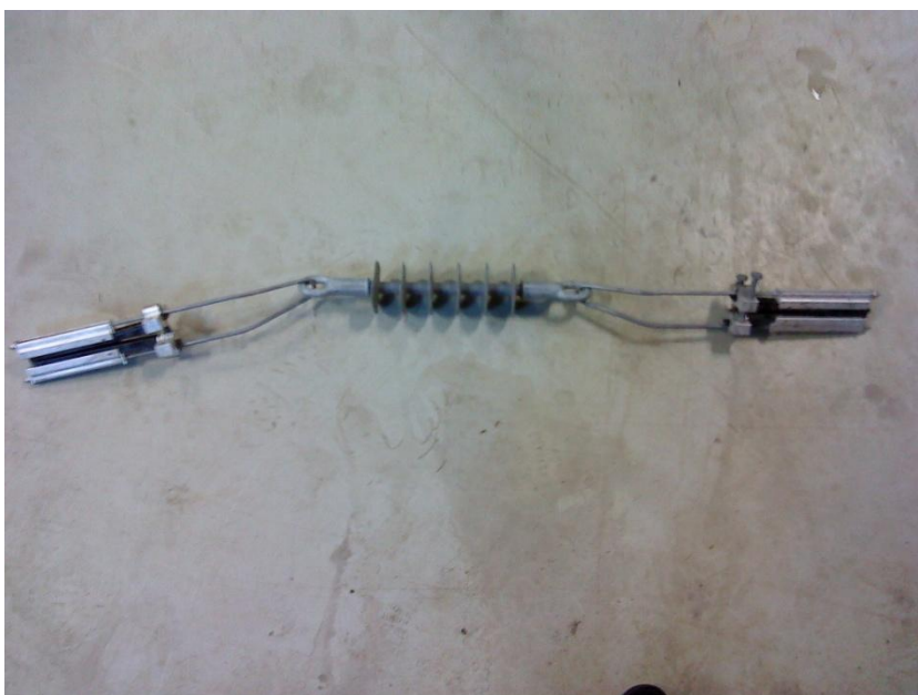
KUVA 6. vielä asentamaton JT katkopaikka
