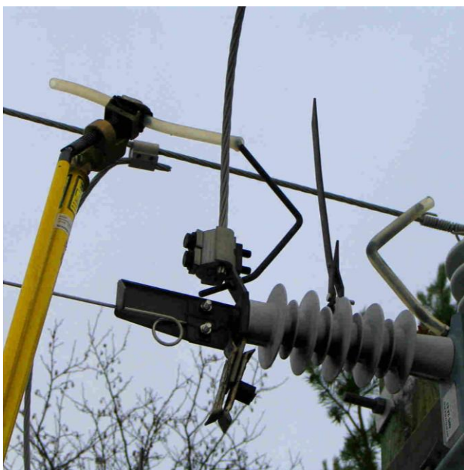
KUVA 8. kipinäsarvien käytöstä poisto silikonisukalla (Pitkänen 2008)
