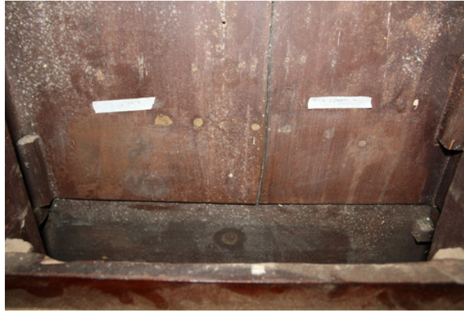
Kuva 53. Homeenpoistoaineen testaus. Oikean puoleinen alue on testattu veden ja kloriitin seoksella (Salminen 2011).
