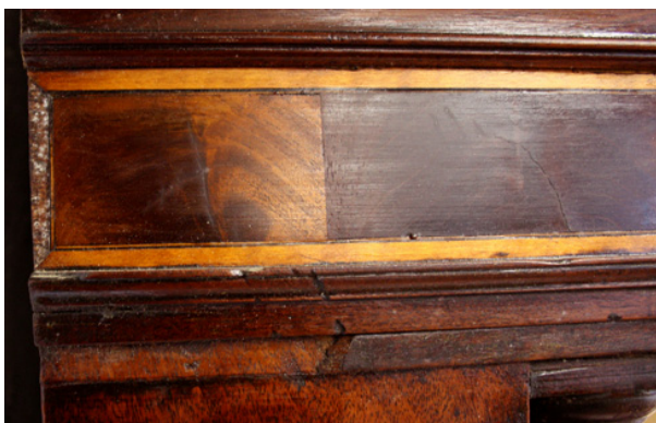
Kuva 3. Vasemman sivun viiluvauriot ennen korjausta (Salminen 2011).
