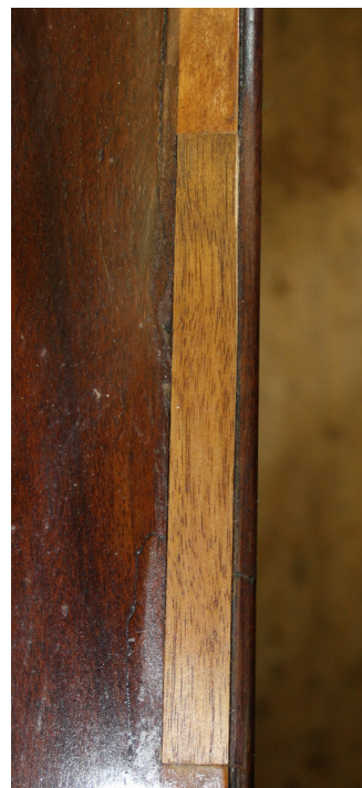
Kuva 10. Oven uusi viilupaikkaus ennen viimeistelyä (Salminen 2011).
