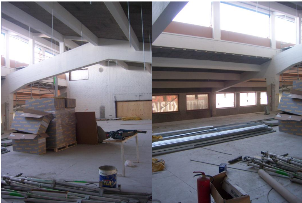
Kuva 5. Rytmikorjaamon Mobile Officen rakennustyömaa.
