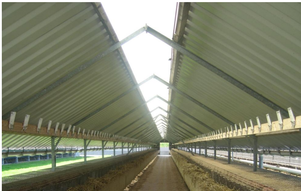
Bild 3. Fönster har installerats i skugghusens tak för att dagsljuset bättre skall nå djuren.
