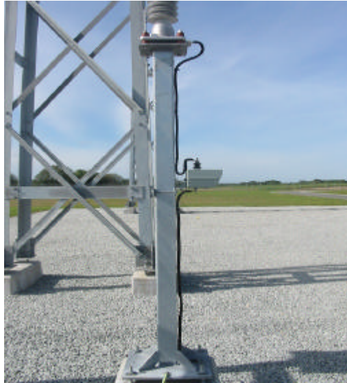
Kuva 22. Ylijännitesuojan maadoitus
