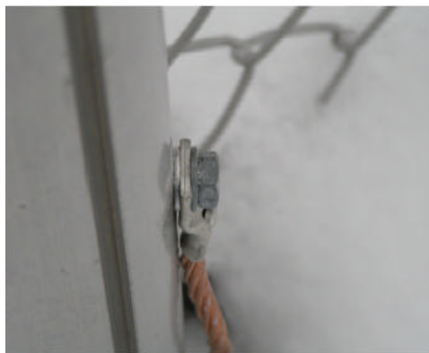
Kuva 17 a) Aidan tolpan maadoittaminen
