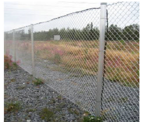
Kuva 17 b) Aidan maadoittaminen
