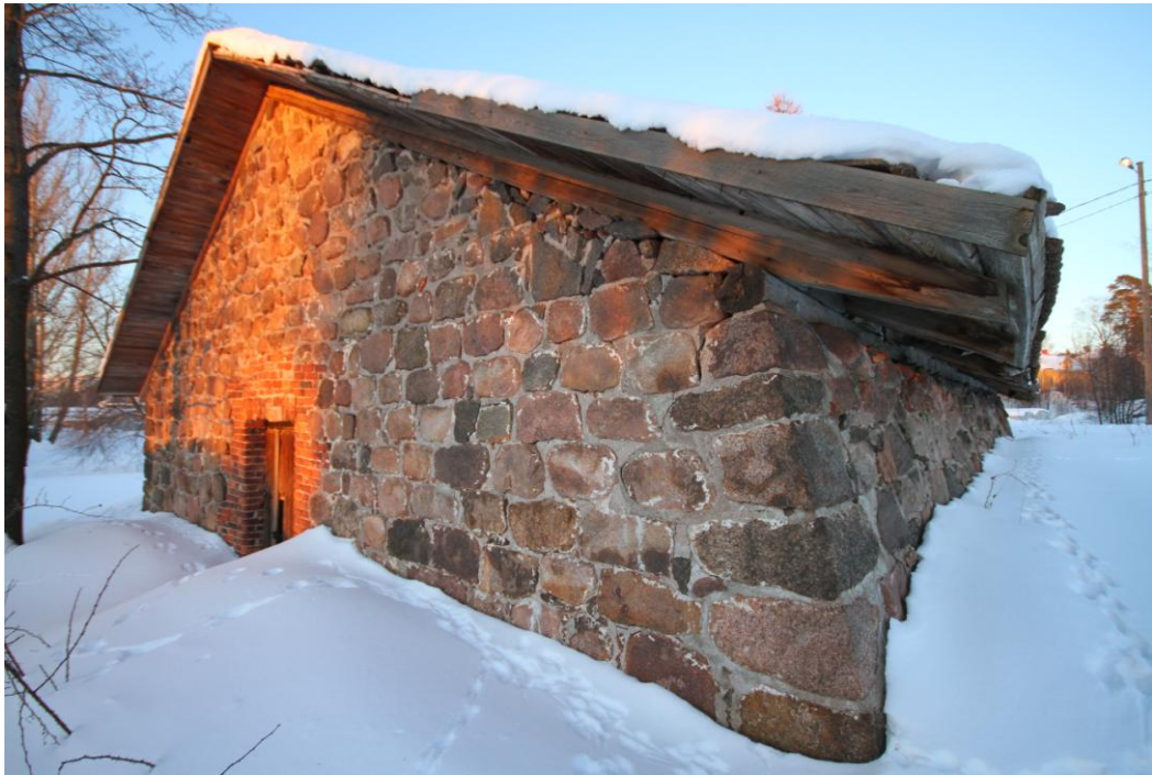
Kuva 3. Katariinassa sijaitseva ruutikellari
