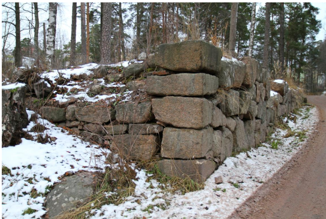
Kuva 23. Raunio nro 83. Jäljellä oleva nurkka ja julkisivu.
