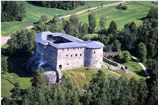
Kuva 22. Raaseporin linna. Vesikate on toteutettu irrallaan olevana muusta rakenteesta. (Museovirasto restauroi 2011.)
