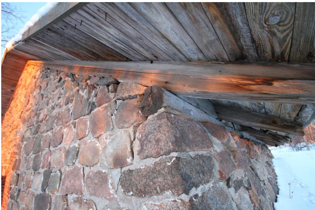
Kuva 4. Katariinassa sijaitseva ruutikellari
