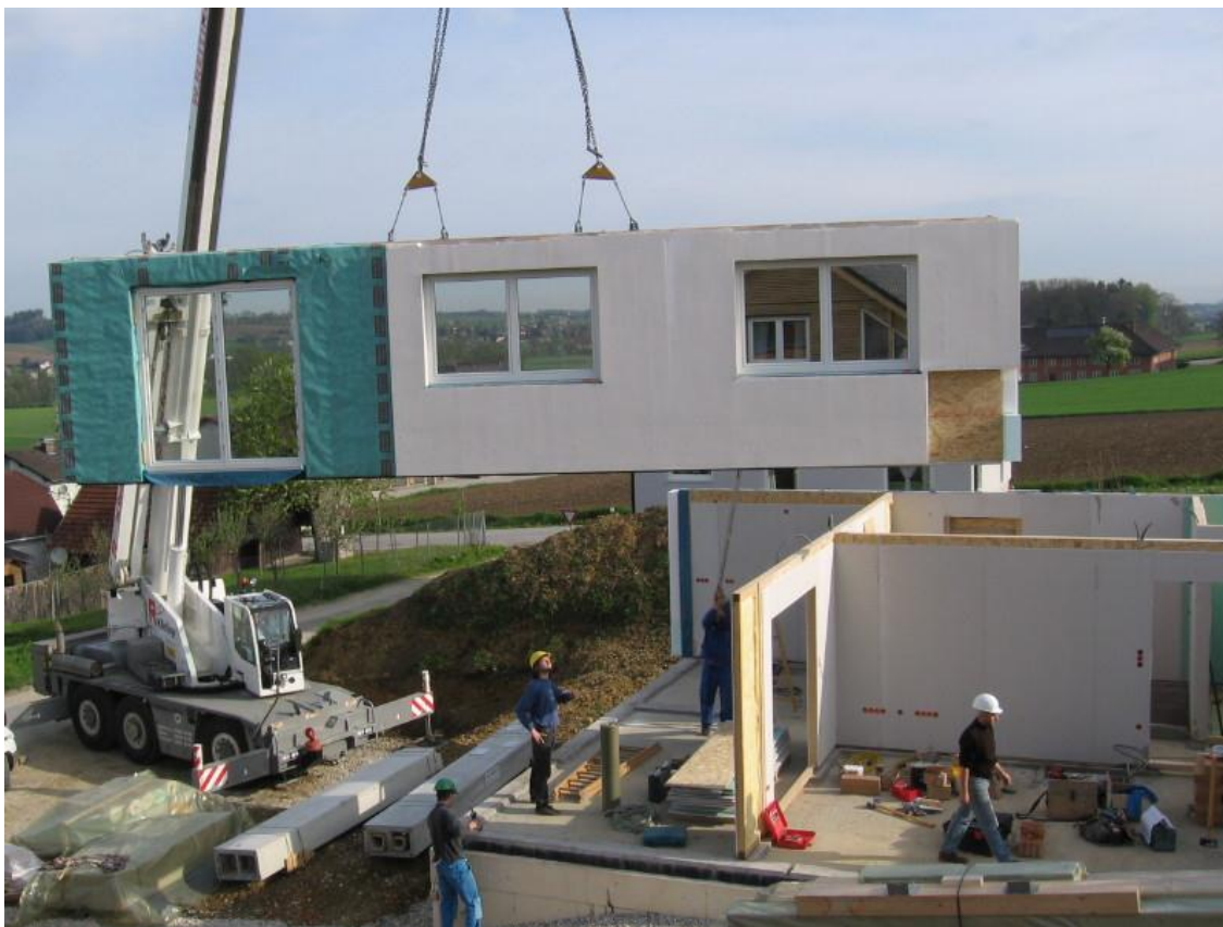
Kuva 3. Suurelementtien asennustyö käynnissä. [12.]
