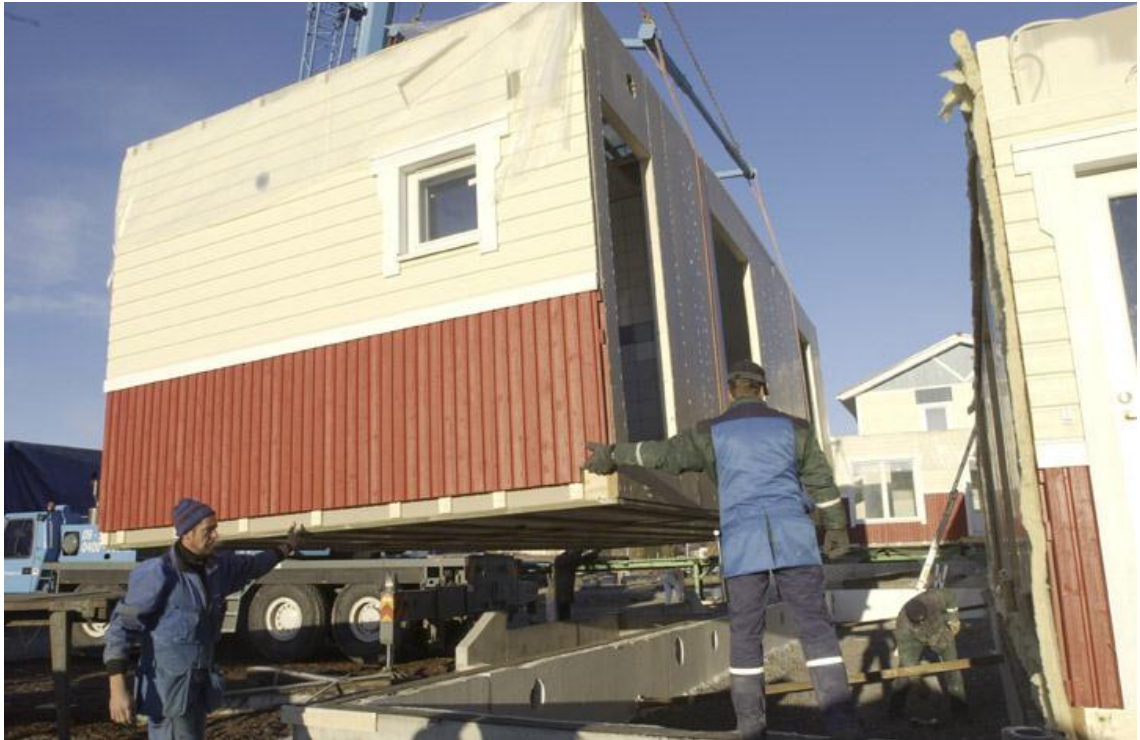
Kuva 4. Tilaelementin asennus paikoilleen. [14.]
