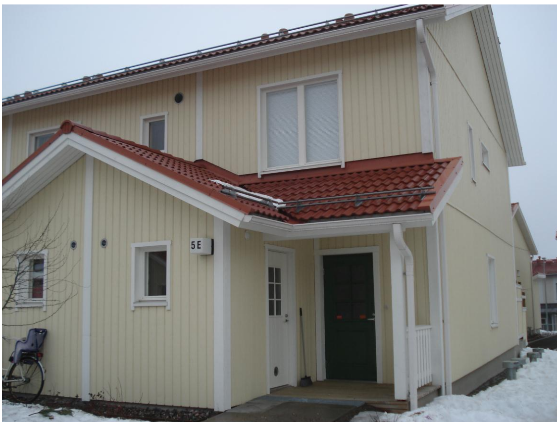
Kuva 11. Elementin pystysaumalista näkyy selvästi julkisivussa.
