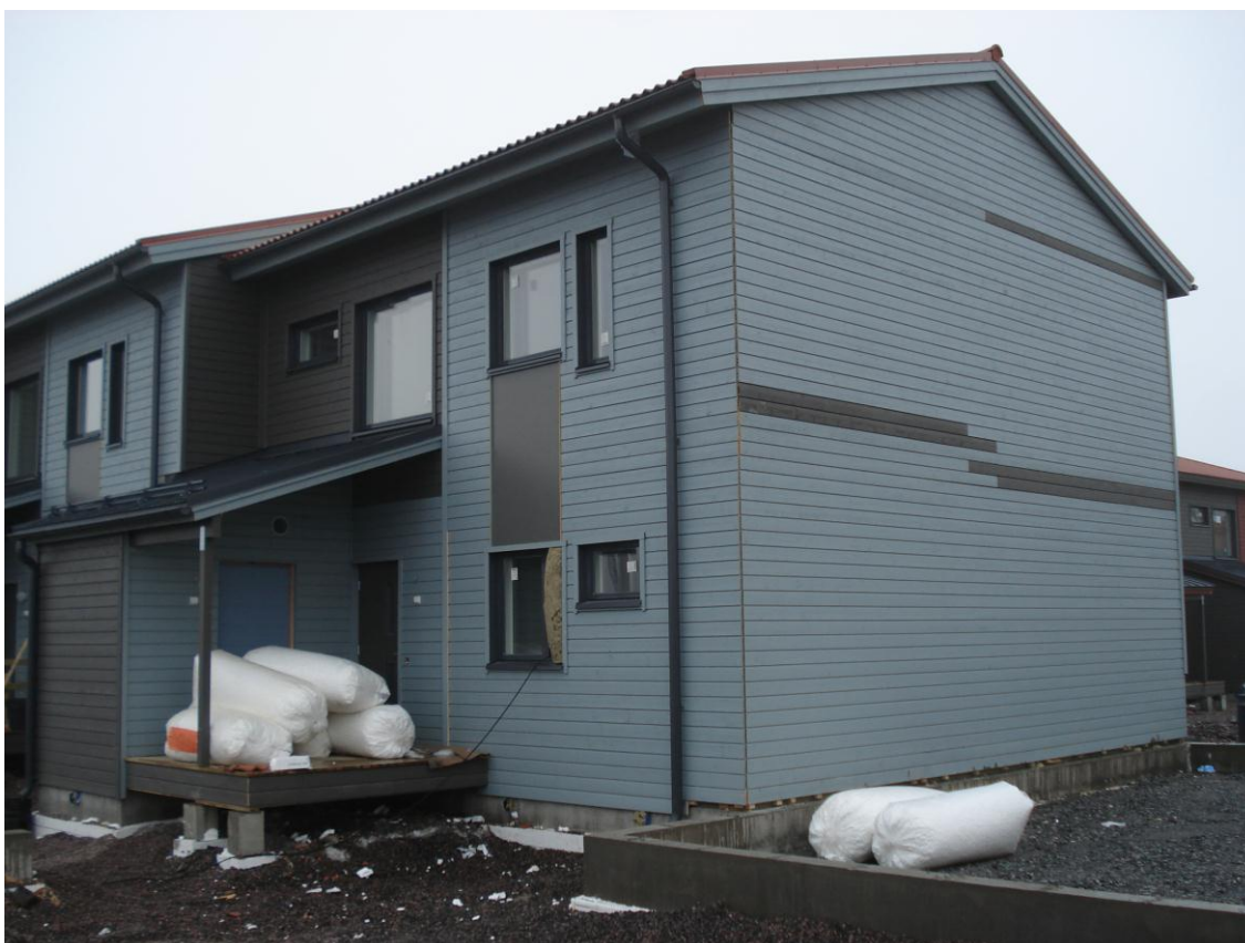
Kuva 7. Tilaelementin vaakasaumat paneelattuna umpeen.
