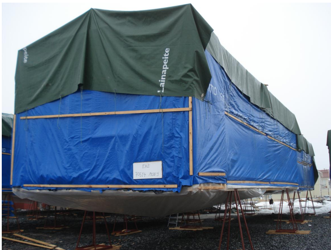
Kuva 8. Tilaelementti väliaikaisessa säilytyksessä.
