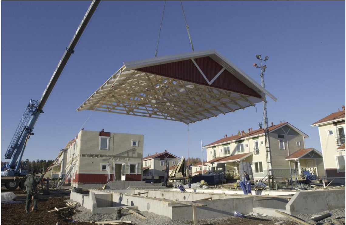
Kuva 6. Perustusten päällä rakennettu katto nostetaan talon päälle. [14.]
