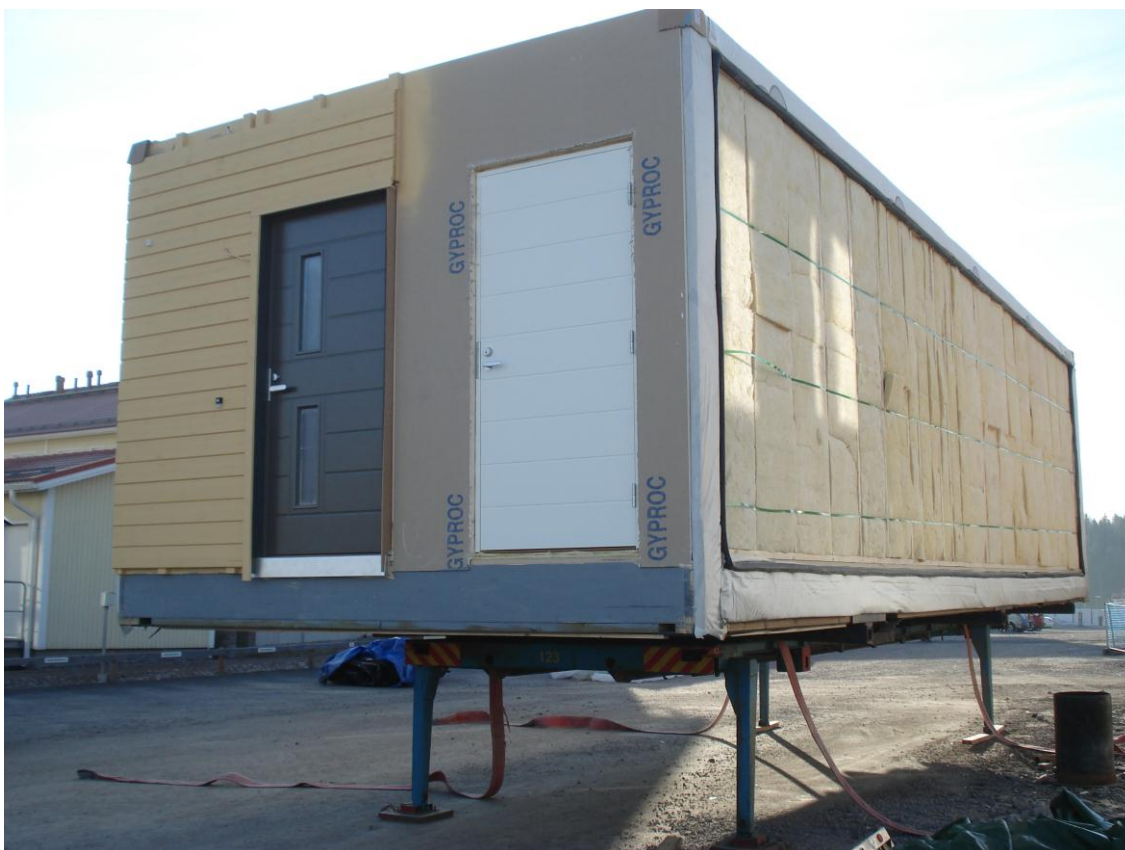
Kuva 10. Tilaelementin paksu alapohja.
