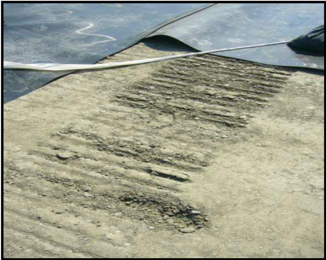
KUVA 5. Poistettavat kaivinkoneen telanjäljet, (kuva Minna Leppänen)
