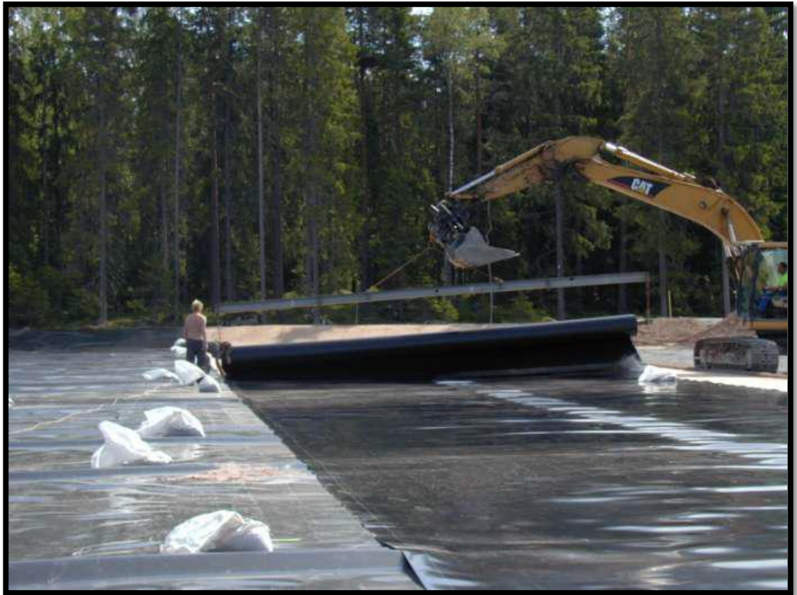
KUVA 6. Kalvon asennus kalvon vierestä, (kuva Minna Leppänen)
