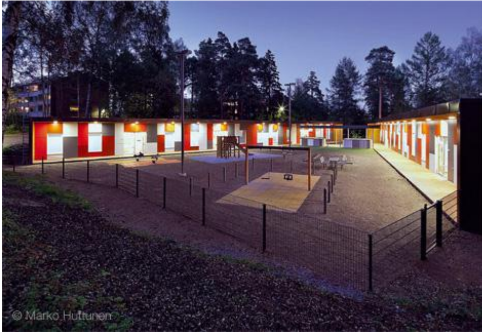
KUVA 1: Julkisivulevyt toimitti Tälli Oy (Kuva: Marko Huttunen 2010)
