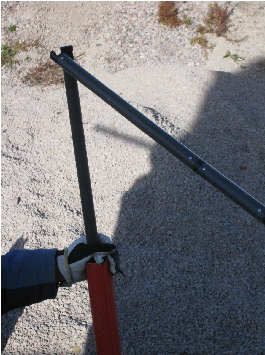
Kuva 4. Inklinometriputken asentaminen jätetäyttöön./33/
