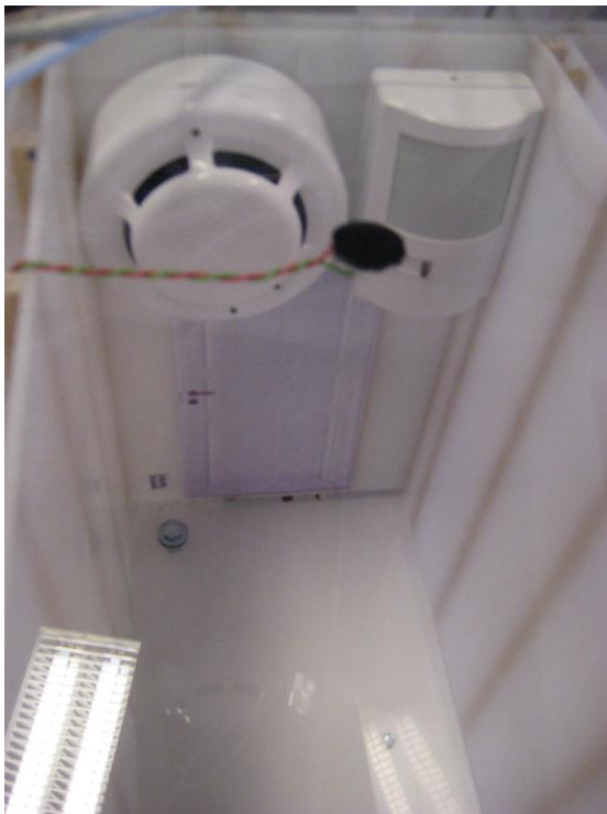
KUVA 26. Kodinhoitohuoneen savunilmaisim ja liiketunnistin
