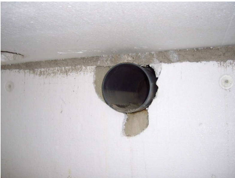
KUVA 6. Alapohjan tuuletuskanava kuvattuna sisäpuolelta
