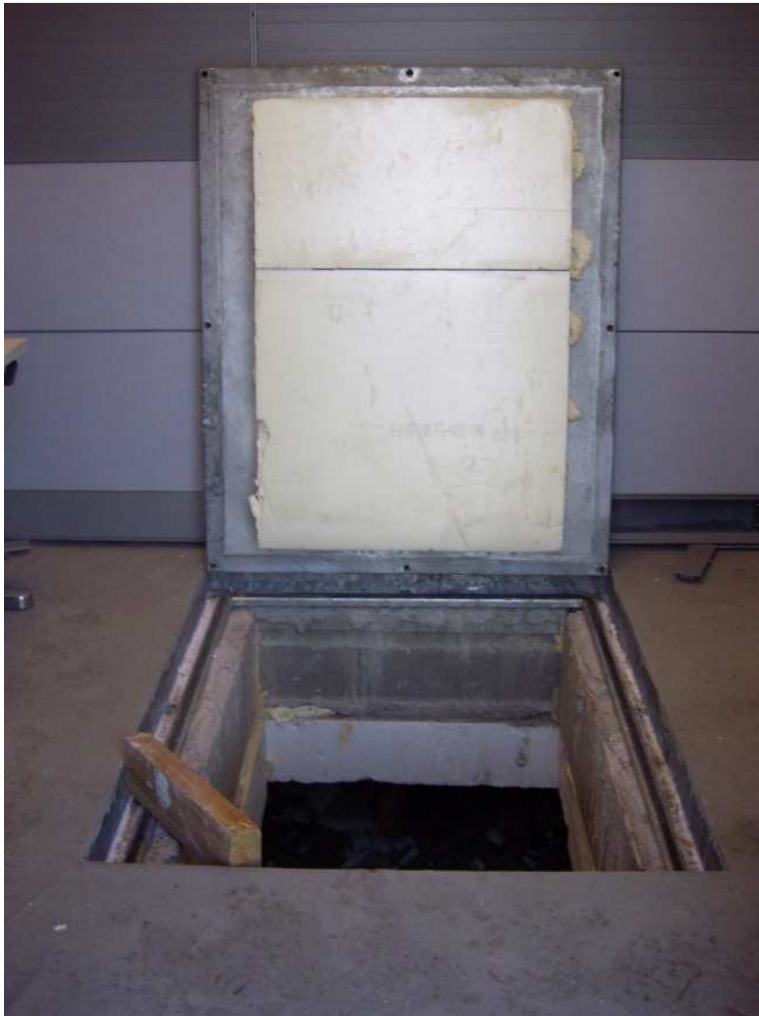
KUVA 7. Terveysaseman alapohjatilan kaasutiivis huoltoluukku
