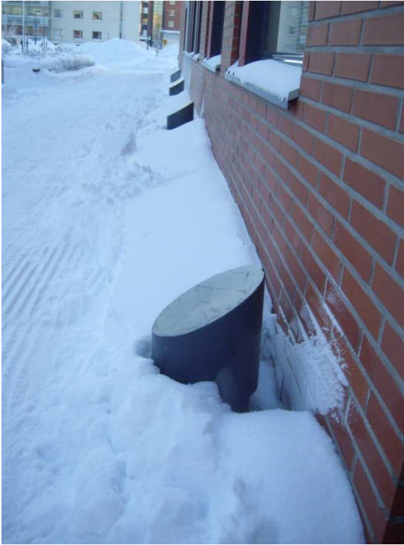
KUVA 5. Terveysaseman alapohjatilan tuuletuskanavia
