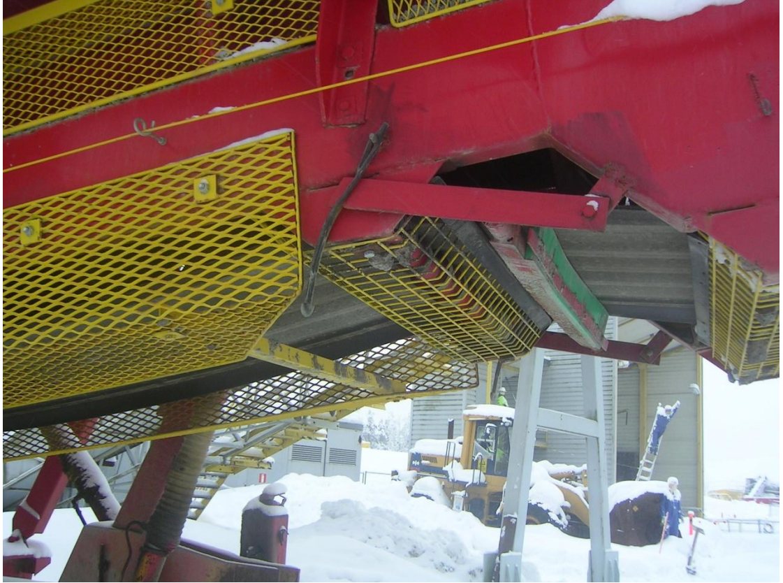
Kuva 3. Oikein tehdyt suojaukset. Kuva Mika Malinen 2011.
