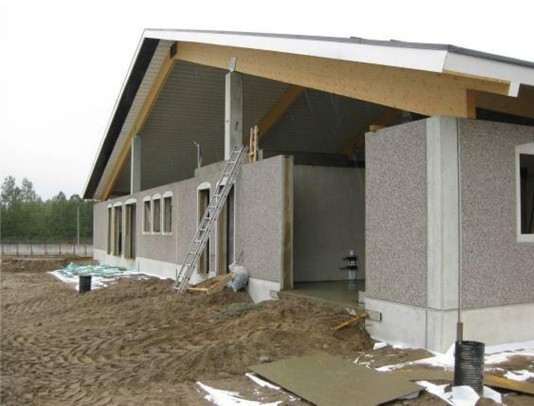
Kuva 2. Kuva päädyn rakennusvaiheesta. Kuva Lujabetoni.
