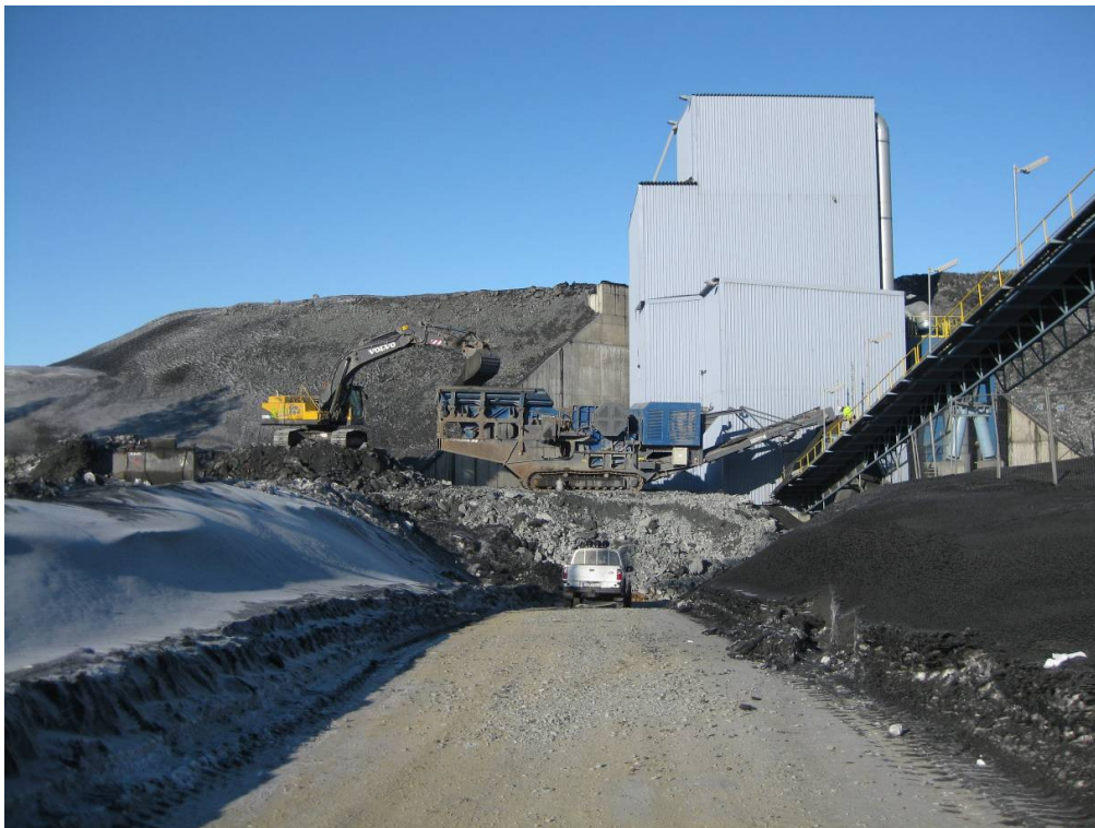
Kuva 1. Murskaamo kevättalvella 2010 ja edustalla on mobiilimurskain ohisyöttämässä malmia pitkälle kuljettimelle.
