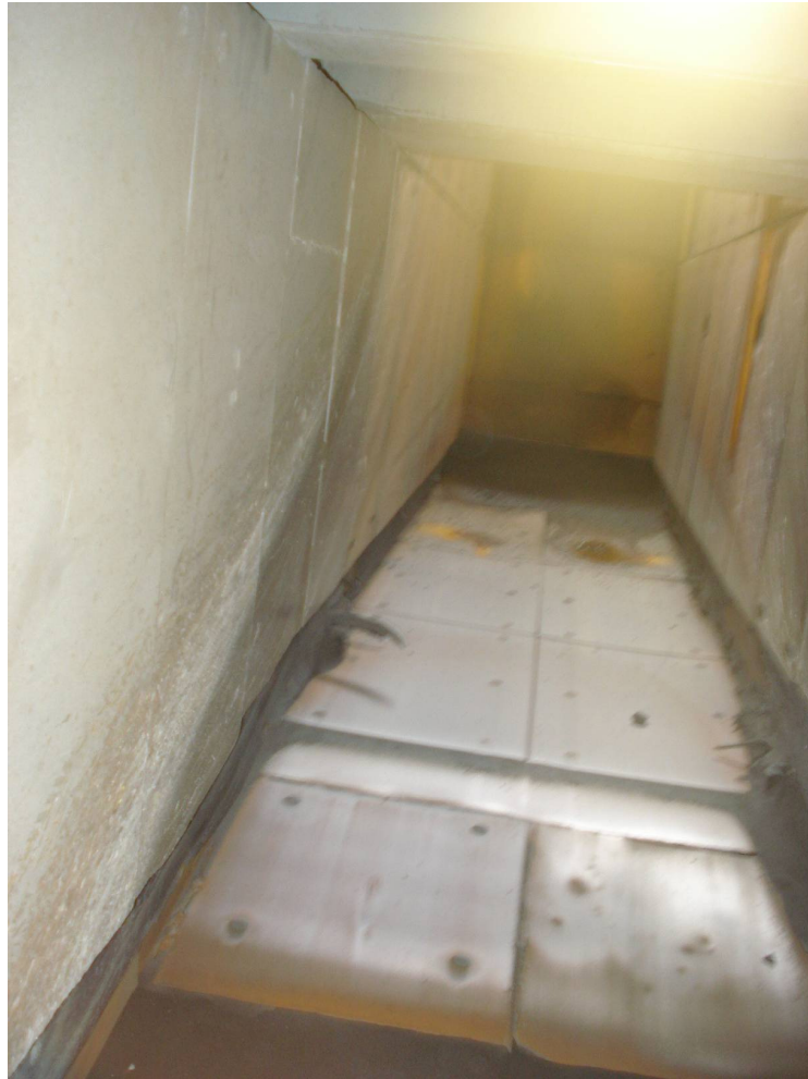
Kuva 8. Tyhjä puhdistettu syötin. Syöttimen puhdistus- ja kulutuslevyjen vaihtotyöt vaativat työturvallisuuden kannalta erityistä huomiota.
