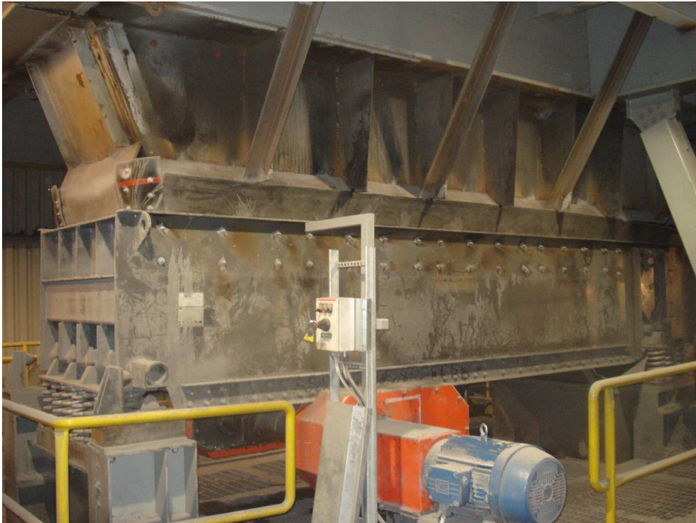
Kuva 5. Syötin moottoreineen asennettu kaatotaskun 1200 mm leveään purkusuppiloon.
