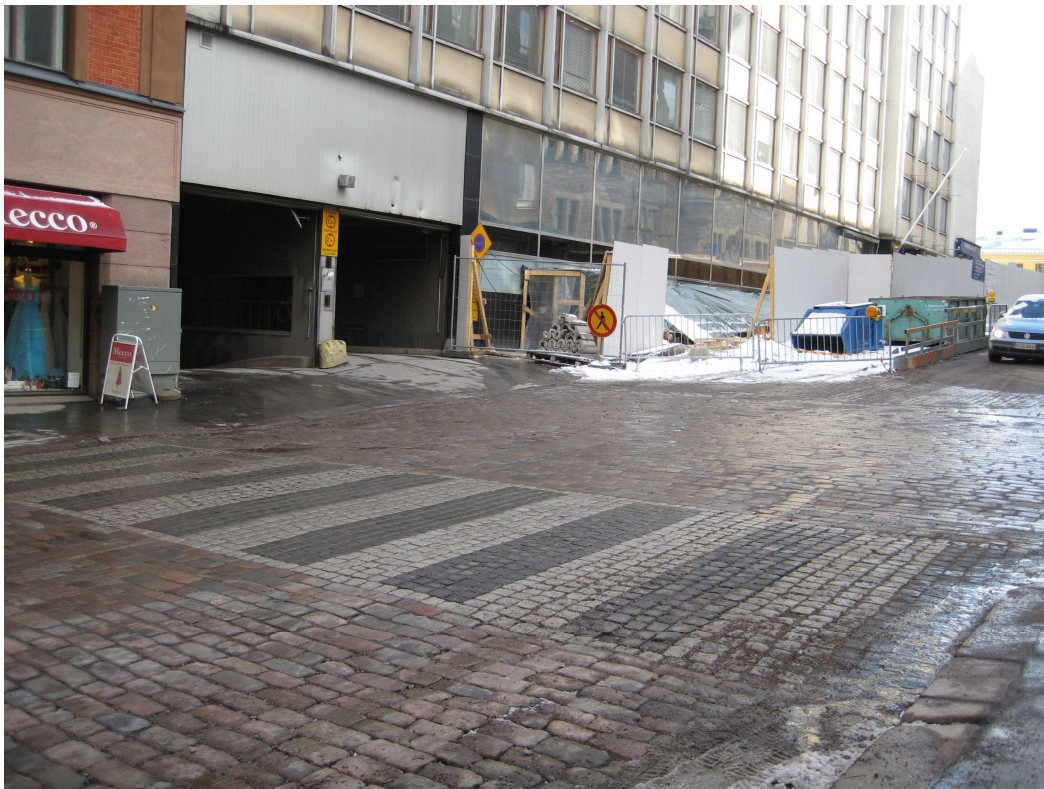
Kuva 22. Kasarmikadun työmaan pohjoispää.
