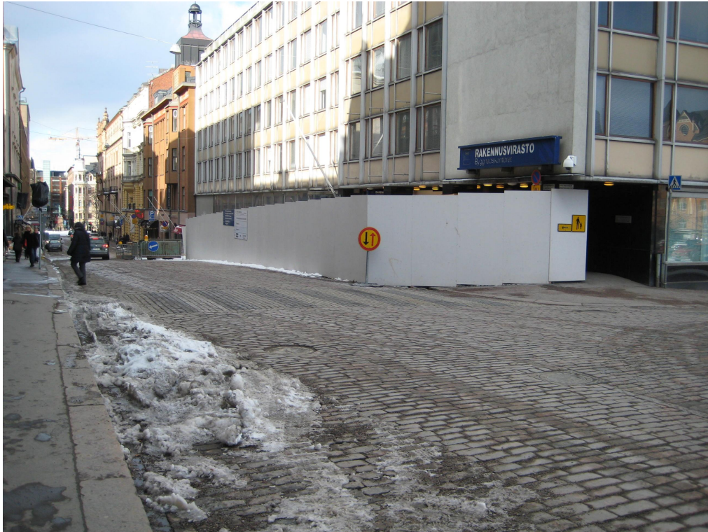
Kuva 23. Kasarmikadun työmaan eteläpää.
