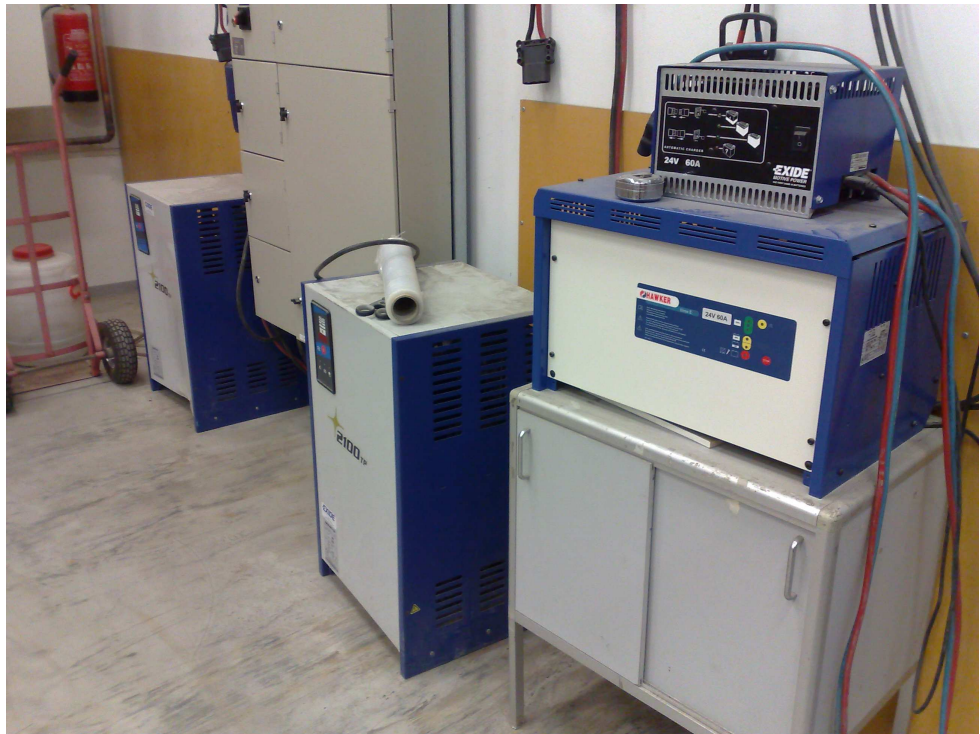
KUVIO 16. Sähkötrukkien latauspiste K-rauta Lahden tavaravastaanotossa (2009)
