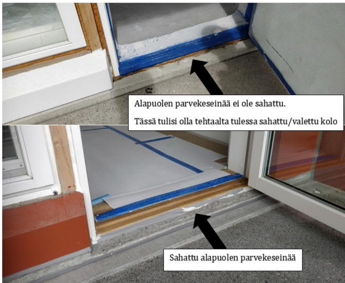
Kuva 17 Seinäelementtiä joudutaan leikkaamaan alemmaksi
