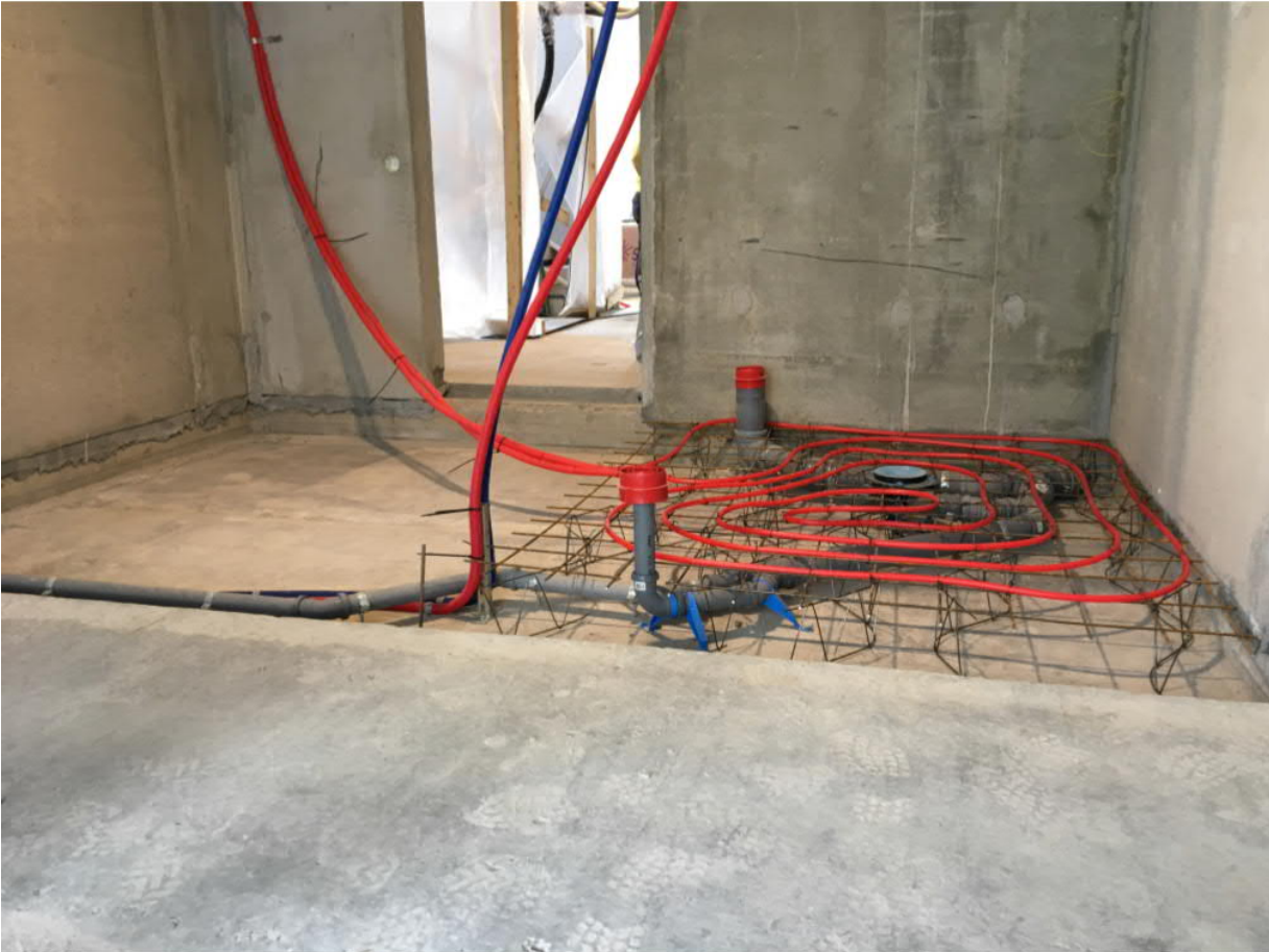
Kuva 3 Kylpyhuoneen lattia ennen valua ja putkiston kulkureitti [7, 21.]
