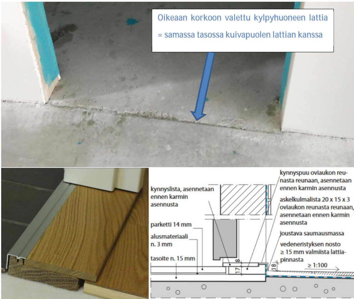
Kuva 5 Kylpyhuoneen ja huoneen liittymäkohta, joka on tehty oikein. vasen alakuva [ http://www.paneliawoods.fi/pdf/pw_vedeneristekynnys_pro.. ], Oikea ala [1, 9.]
