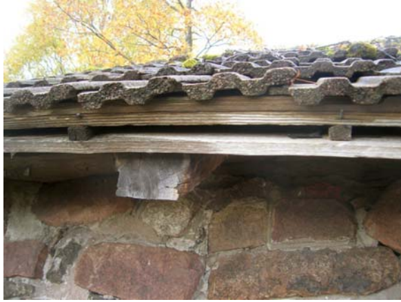
Kuva 17. Kellarin katteen rakenne näkyy räystäältä hyvin.
