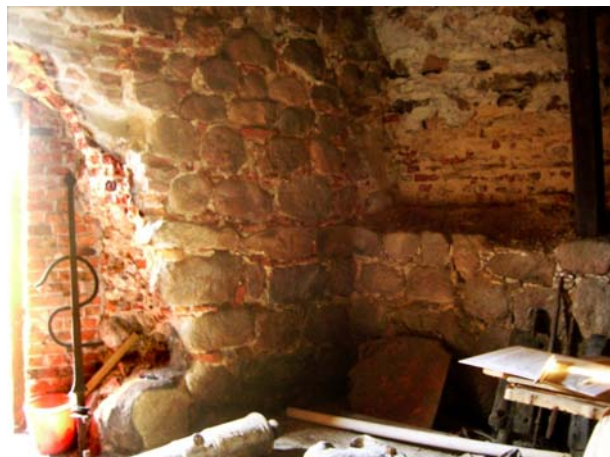
Kuva 34. Etuhuoneen holvin puuttuessa on seinärakenne hyvin nähtävissä.
