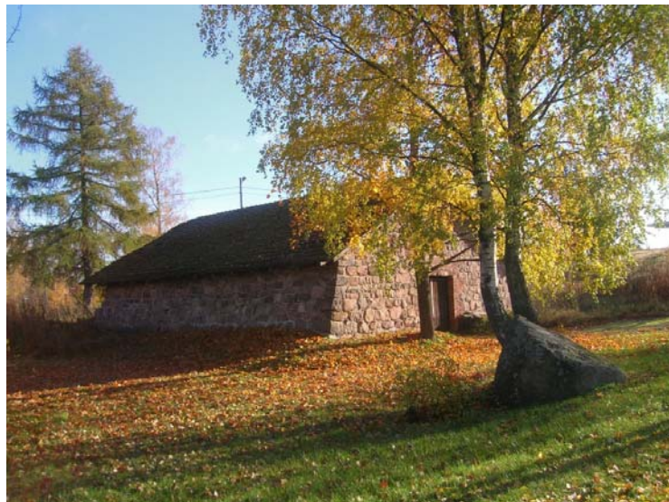
Kuva 14. Yleiskuva kellarin pohjoispuolelta. Maa kellarin vierellä on noussut korkeimmillaan yli metrin.
