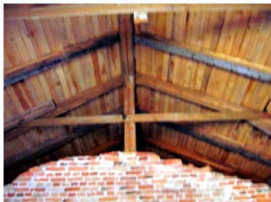
Kuva 18. Kurkihirren kannatus tolppien varassa takahuoneen holvin päällä. Tolppien kohdalla on myös kitapuut sitomassa rakennetta.
