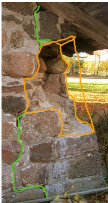
Kuva 36. Koillisnurkalla uudelleenmuurausta vaatii oranssilla merkityn osan kokoinen pala. Vihreällä on merkitty halkeama, joka tulee tutkia.
