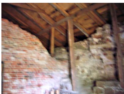
Kuvat 30 ja 31. Tolpat kannattelevat parrua, jonka päälle katonkannattajat tukeutuvat. Osa katonkannattajista on jatkettu tai tuettu toisella hirrellä.
