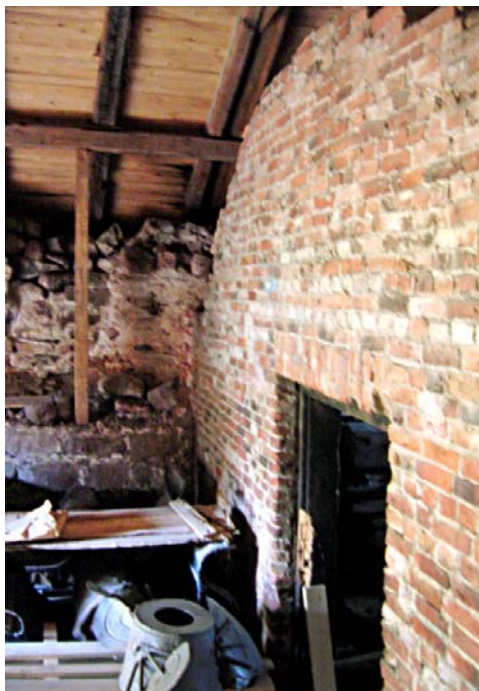
Kuva 19. Väliseinän yläreuna noudattaa holvin muotoa.
