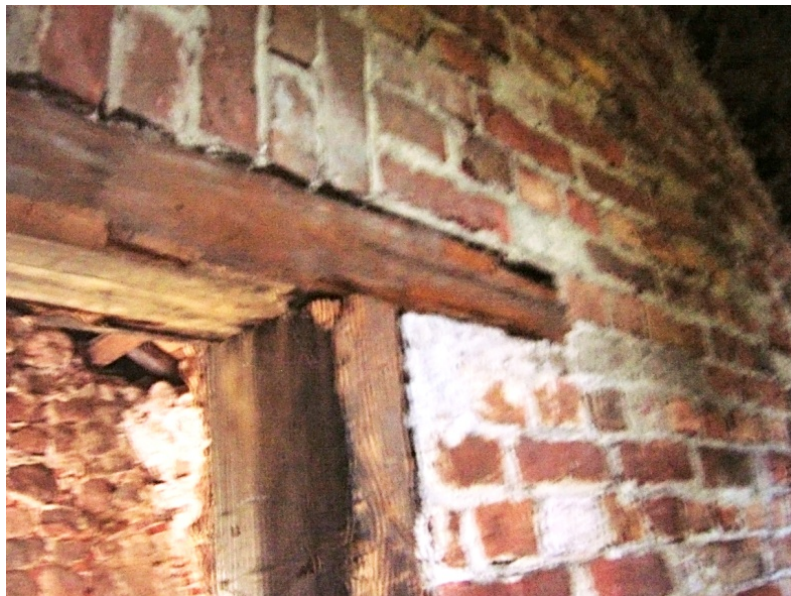
Kuva 23. Välioiven yläkarmissa on pitkät päät, jolloin karmi toimii väliseinää tukevana palkkina.
