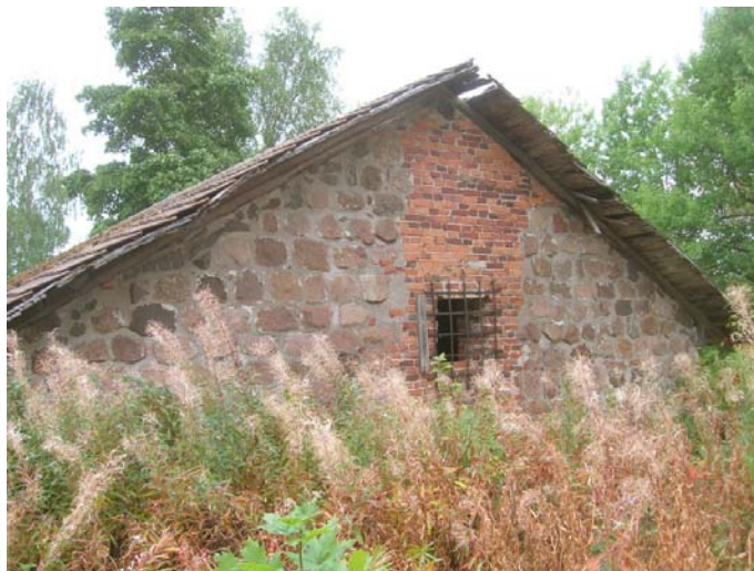
Kuva 21. Kellarin ainoa ikkuna itäpuolelta kuvattuna.
