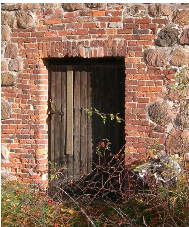
Kuvat 22. Ulko-ovi sijaitsee kellarin länsipäädssä.
