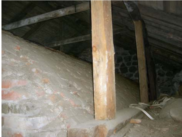
Kuvat 35. Takahuoneen holvi päältä kuvattuna.
