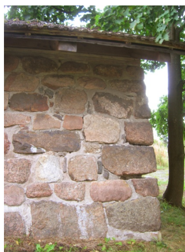
Kuvat 25 ja 26. Kellarin luoteisnurkalla pystysuuntainen, suora halkeama näkyy länsiseinän puolella (vas.). Pohjoisseinän puolella halkeamaa ei näy (oik.).
