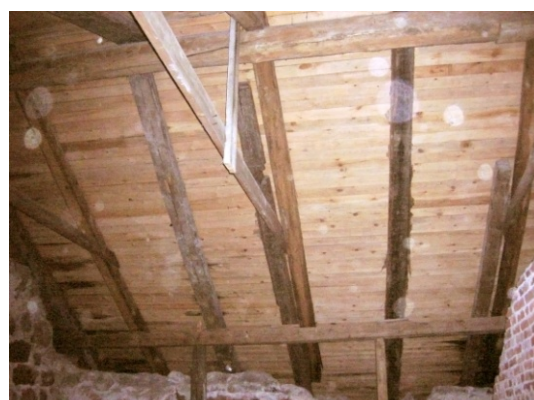
Kuvat 30 ja 31. Tolpat kannattelevat parrua, jonka päälle katonkannattajat tukeutuvat. Osa katonkannattajista on jatkettu tai tuettu toisella hirrellä.
