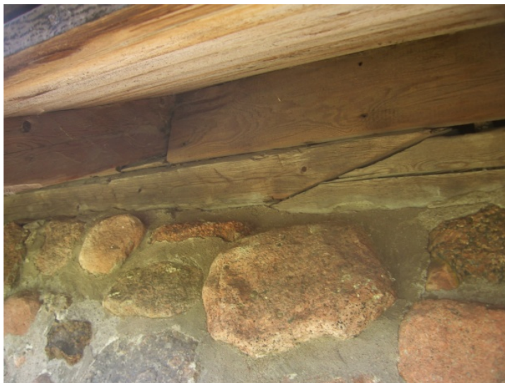
Kuva 32. Sivuseinän päällä lepäävä palkki ottaa vastaan katonkannattajien painoa. Yksi katonkannattaja näkyy kuvan vasemmassa laidassa ja välejä peittävä lauta palkin päällä.
