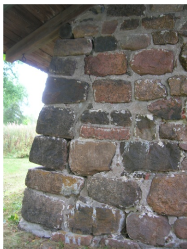
Kuvat 25 ja 26. Kellarin luoteisnurkalla pystysuuntainen, suora halkeama näkyy länsiseinän puolella (vas.). Pohjoisseinän puolella halkeamaa ei näy (oik.).
