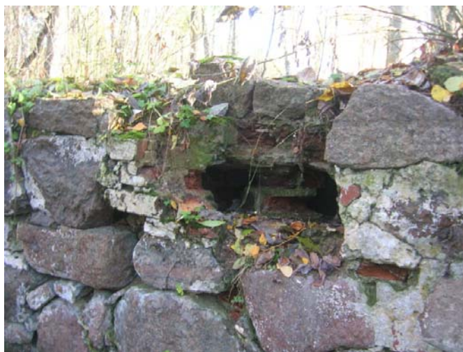
Kuva 11. Raunioituneen ruutikellari nro 82:n tuuletusaukko.
