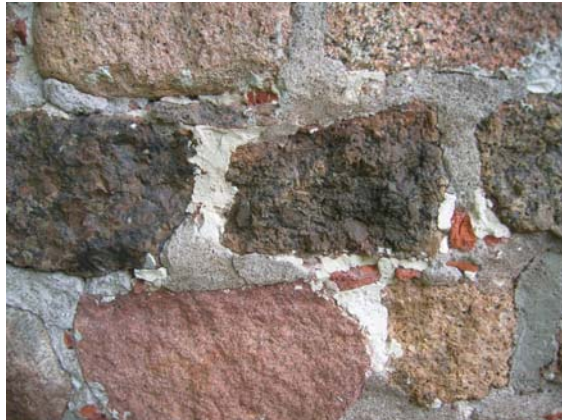
Kuva 15. Kiviseinän muurausta kellarin länsiseinällä. Tiilenpaloja on käytetty saumojen täytteenä ja kiiloina pienten kivien tavoin.
