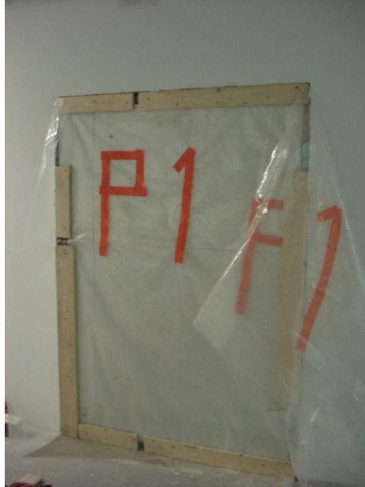
Kuva 8. P1-puhtausluokan vaatima oviaukon suojaus.
