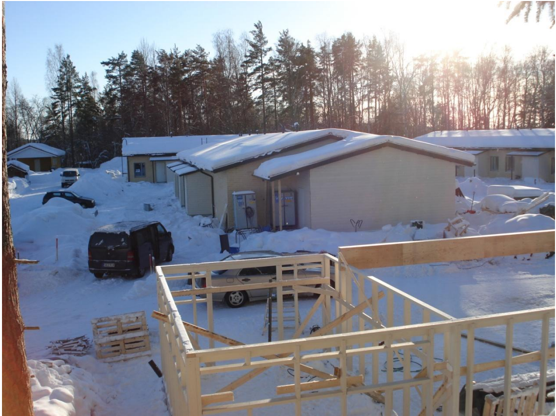
Kuva 2. Työmaa 1, As.Oy.Heinolan Kultasiipi.
