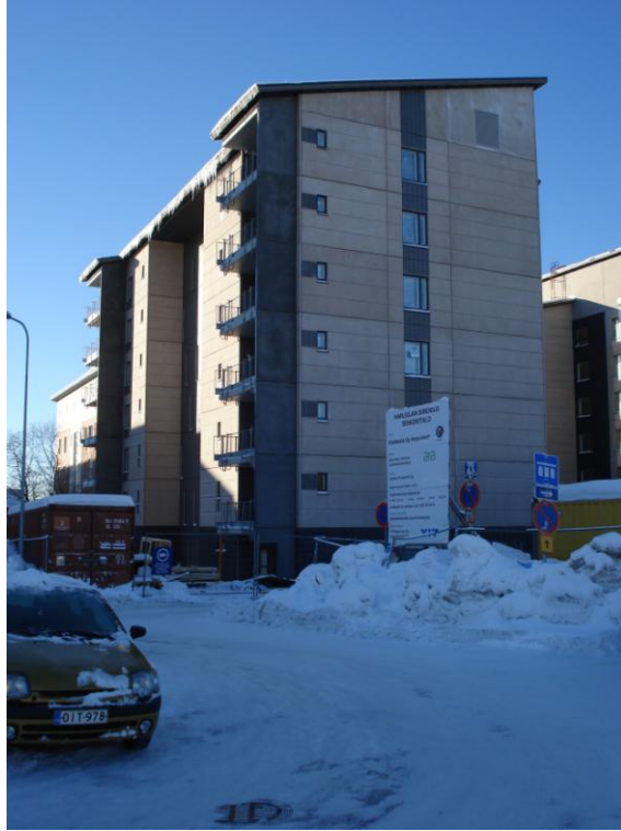
Kuva 10. Työmaa 5, As. Oy Kallioistenkatu 5.
