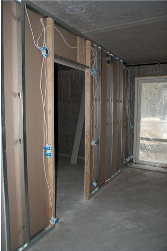
Kuva 2. Kipsilevyseinä, jossa levyt on asennettu vain toiselle puolelle runkoa. Sähköasennusten jälkeen levyt asennetaan myös rungon toiselle puolelle.
