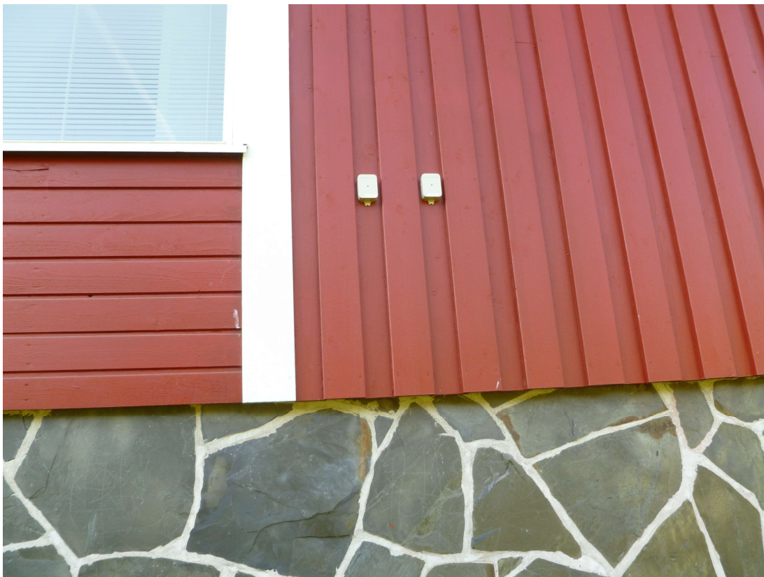
Kuva 4. OptiWatti-järjestelmän ulkoanturit sijoitetaan pohjoisen puolelle. Kuva on Kodistuvalla.
