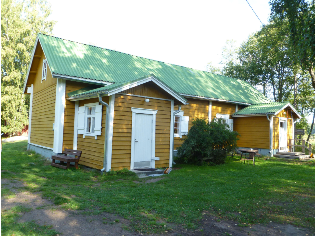
Kuva 8. Karvatin keittiö- ja ruokailurakennus.
