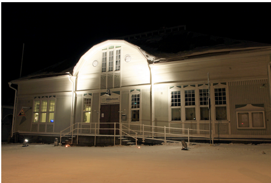
Kuva 3. Pakkahuone valaistiin esityspäivinä illan hämärtyessä. (Kuva: Tuukka Pakarinen.)
