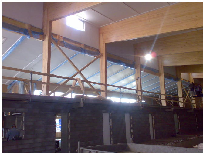
Kuva 15, Sipoon harjoitusjäähalli sisältä rakennusaikaisessa vaiheessa
