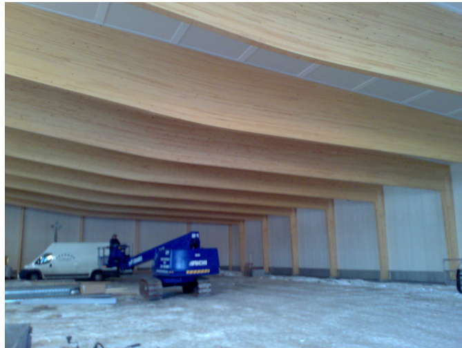
Kuva 14, Sipoon harjoitusjäähalli sisältä rakennusaikaisessa vaiheessa
