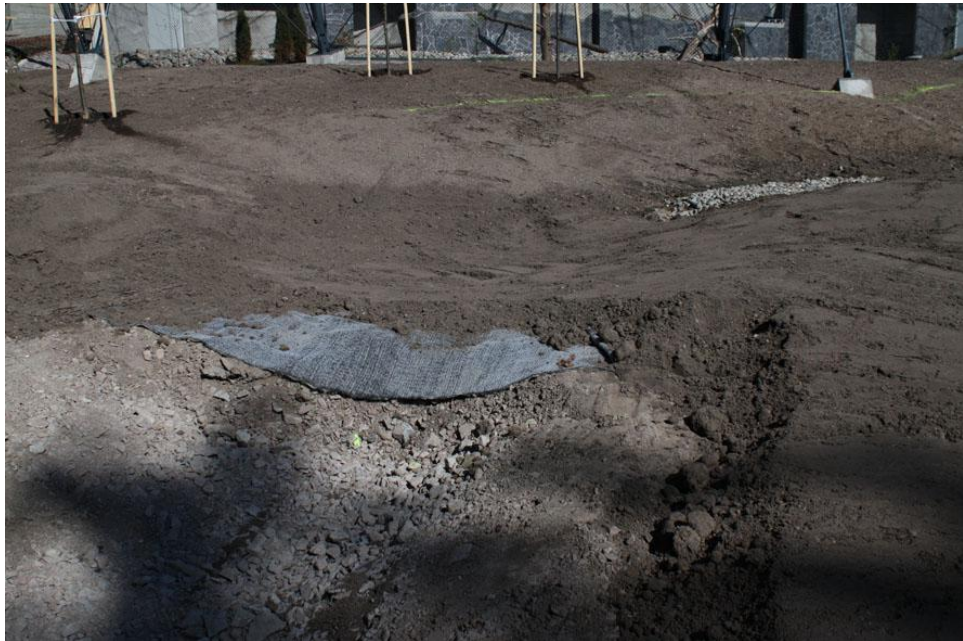
Kuva 8: Vettä pidättävä allas tiivistettiin savella ja bentoniittimatolla. Maton päälle asennettiin kasvualustakerros, joka myöhemmin verhoiltiin vielä irtokivillä eroosion estämiseksi.
