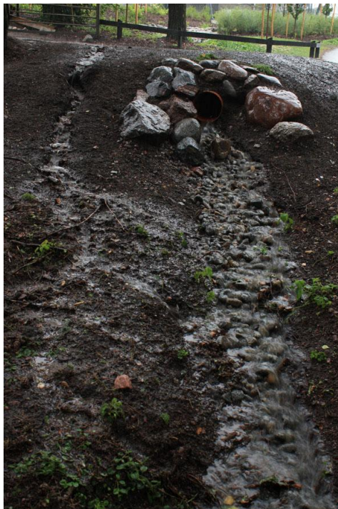
Kuva 12: Irtonainen kasvialusta on herkkä eroosiolle ennen kun kasvillisuus sitoo sen maahan.
