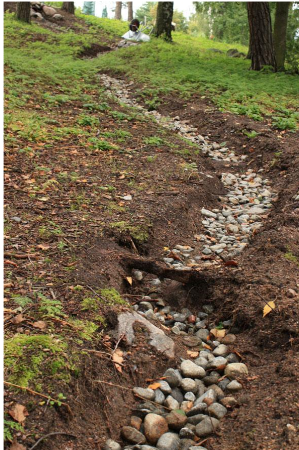
Kuva 7. Alajuoksulla painanne kaivettiin metsänpohjaan juuria varoen ja sen pohja suojattiin eroosiolta irtokivillä. Vesi ohjautuu alueella luontaisesti sijainneeseen painanteeseen.
